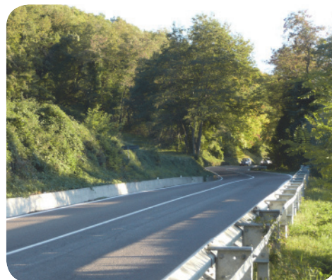
6 . Percorrendo la strada dell'Abetone verso Montecuccolo.
