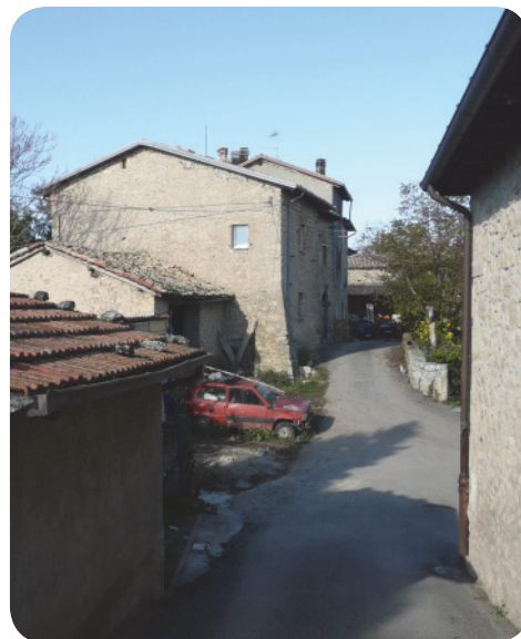
6 . Secondo ordine di cortina muraria (a sx fianco della chiesa).
