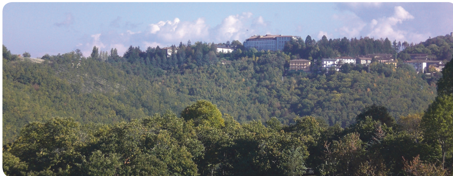
1 . Verso Gaiato . al centro della composizione paesaggistica svetta la mole imponente del sanatorio di Gaiato.
