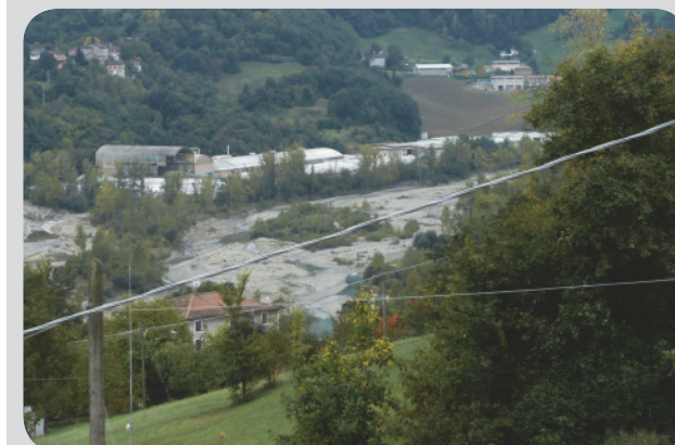
9 . Vista complessiva delle attività produttive localizzate lungo la riva del Dolo.
