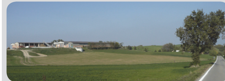
3. località Possessione: capannoni costruiti intorno al nucleo storico del complesso rurale.
