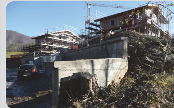
18. edifici in via di realizzazione (a sud-ovest del bene, ai limiti del perimetro).
