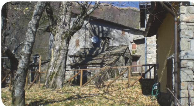
15. il borgo de Le Valdare . gli edifici risultano molto modificati.
