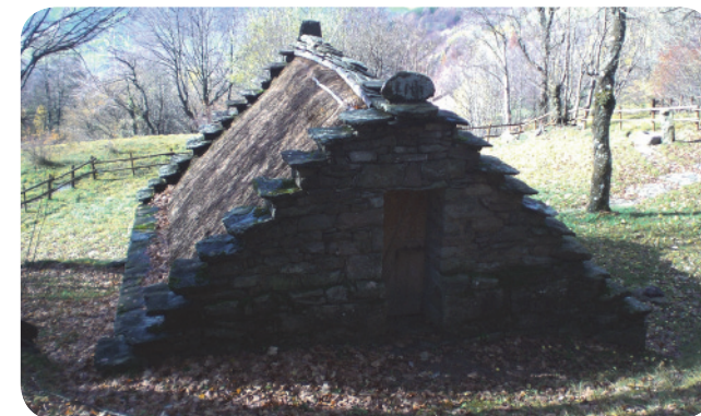
14. Casa della Rosa . prospetto laterale e ingresso al piano superiore (avente funzione di fienile) della capanna a monte. L'edificio è stato ristrutturato e oggi ha funzione didattica [si veda anche foto 9]
