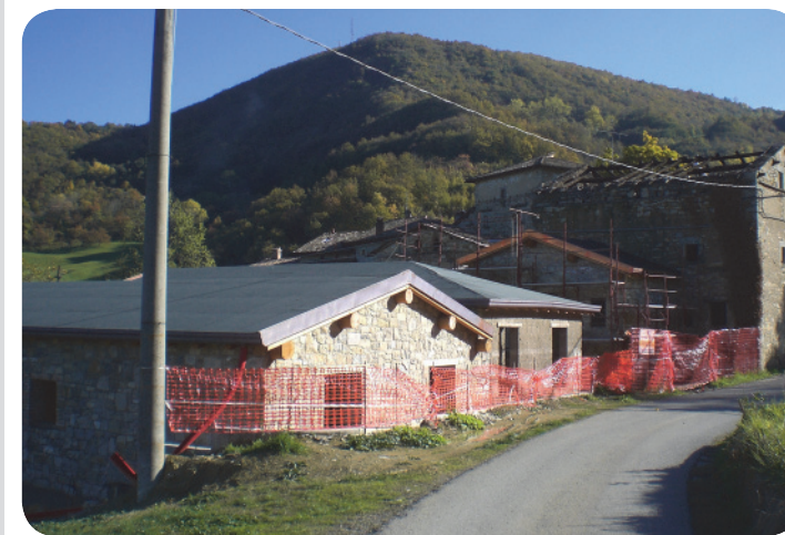
3 . Vista dell'intervento da via Caprasecco verso Borgo Valle.
