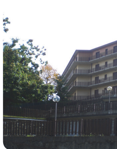
2 . Albergo . costruito a ridosso del parco dei castagni.
