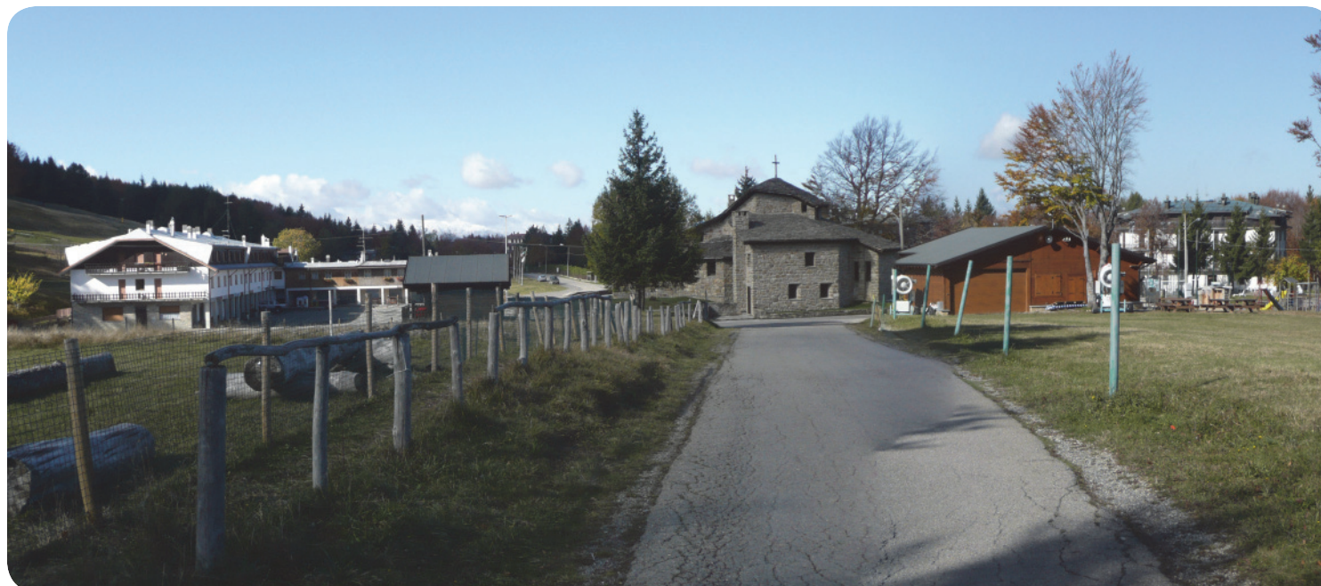
6 . Vista sul retro della chiesa della località Piane di Mocogno, affacciata sulla piazza che si intravede dietro l'edificio di culto.
