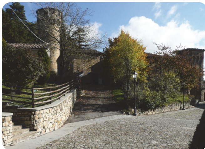
1 . Castello . l’accesso avverrebbe dalla torre che si scorge in fondo, sulla destra.
