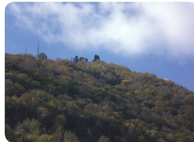
4 . dettaglio . dalla vegetazione si intravedono le antenne e le torri del Castello.
