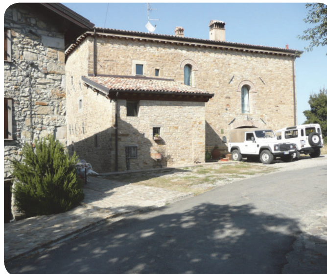
4 . Uno degli edifici più rilevanti del borgo, restaurato (non è stato possibile risalire alla data di realizzazione dell'annesso incongruo, comunque antecedente al restauro).
