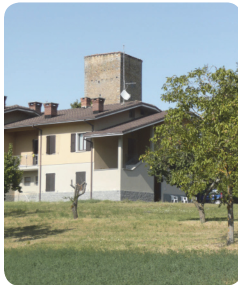
1 . Torre della Bastiglia e nuovo edificato.
