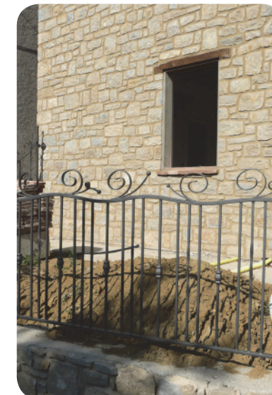
6 . Restauro in essere durante il sopralluogo, si noti la pietra usata come rivestimento.
