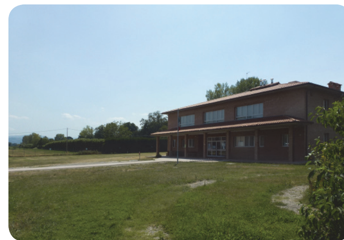
8 . Scuola . Facciata principale su via Don Luigi Orione; sullo sfondo il recinto verde.
