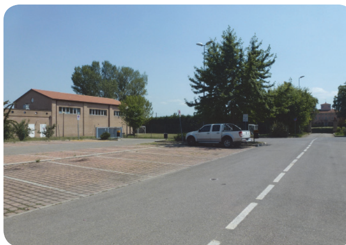
7 . Scuola . Parcheggio posto sul retro dell'edificio; sulla destra, accesso alla villa.
