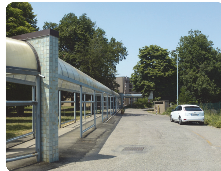
9 . Ingresso della scuola da via Ghiarella (tratto a fondo chiuso).
