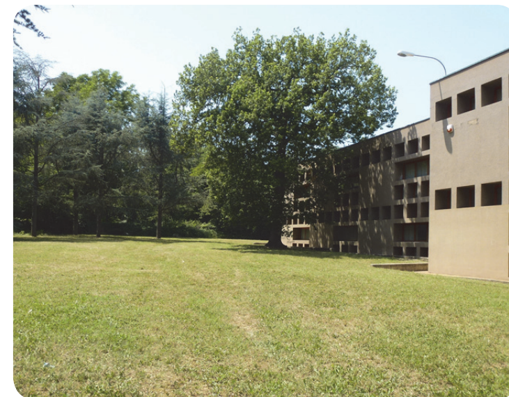
7 . Vista dalla scuola verso il parco.
