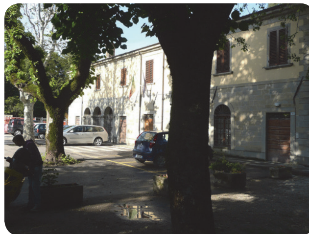
10 . L'ex macello comunale, circondato dal parco pubblico attrezzato anche con campi da tennis: a sx la facciata principale su via lungo Savio; a dx la facciata verso il Savio.
