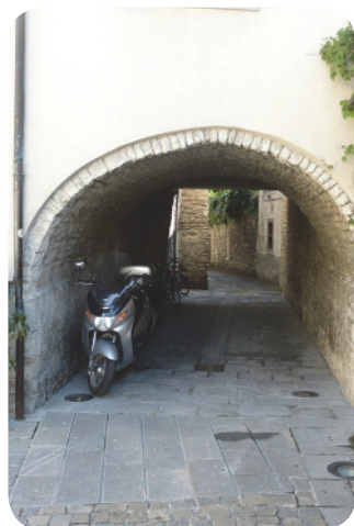
8 . Cavalcavia con edificio soprastante.
