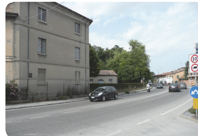
2 . Gli annessi alla villa, con accesso sulla via Emilia. Più avanti, a sx si ritrova la vegetazione ad alto fusto del parco, mentre a dx si vede la cortina muraria del centro urbano.
