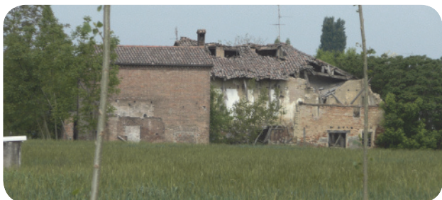
15. casa ciapadora con evidenti crolli strutturali. Talvolta non si ristruttura l'abitazione tipica per poter acquisire la volumetria necessaria alla costruzione di nuovi edifici.
