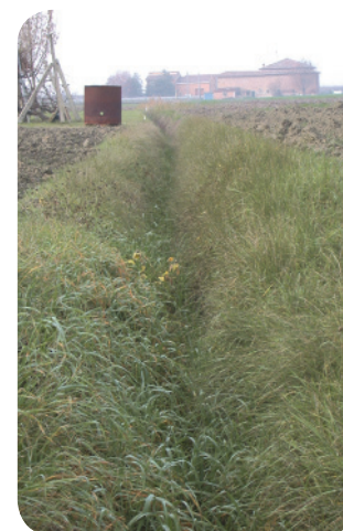
7. tramarello . in stato di abbandono.
