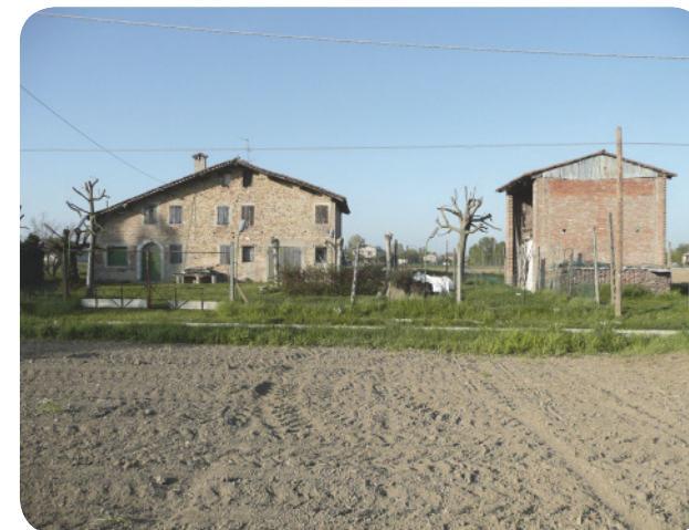
11. abitazione dalla tipica morfologia a falde asimetriche. Il fronte dell’abitazione si caratterizza per l’accesso posizionato lateralmente e per le aperture poste nella zona di conclusione dell’involucro (sulla destra della facciata). si notino inoltre: la presenza della casella e del pozzo, nonché l’esposizione a meridione.
