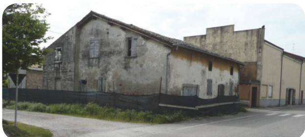
14. edificio tradizionale con superfettazioni e in evidente stato di abbandono.
