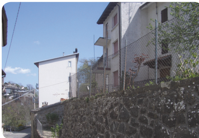
4 . La parte più nuova dell'abitato, con caratteristiche edilizie "distratte" rispetto al contesto.
