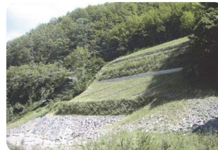
5 . L'area di frana due anni dopo l'intervento di sistemazione (2002)
