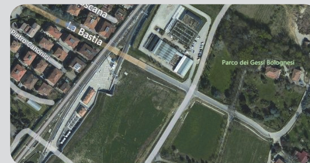
8 . Il recente sottopassaggio dell'alta velocità ferroviaria costruito a ridosso dell'esistente ferrovia Bologna-Firenze.
