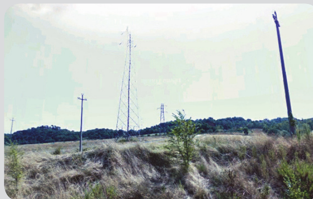
6 . Pali di elettrodotti nella parte meridionale della zona tutelata.
