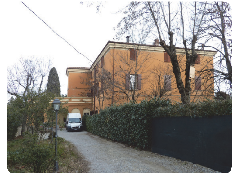
5 . La siepe alla fine del viale che crea una chiusura prospettica.
