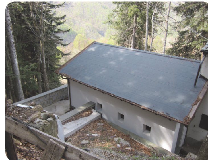
4 - L'estensione del santuario: il retro visto dall'alto. Il nuovo volume modifica la percezione lungo il sentiero oltre il santuario.
