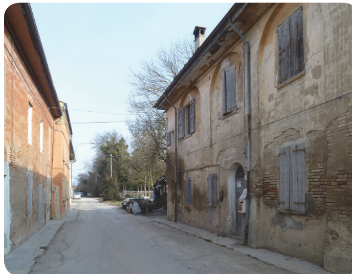
3 - Stradello del borgo: a dx cortina storica; a sx cortina di più recente costruzione.
