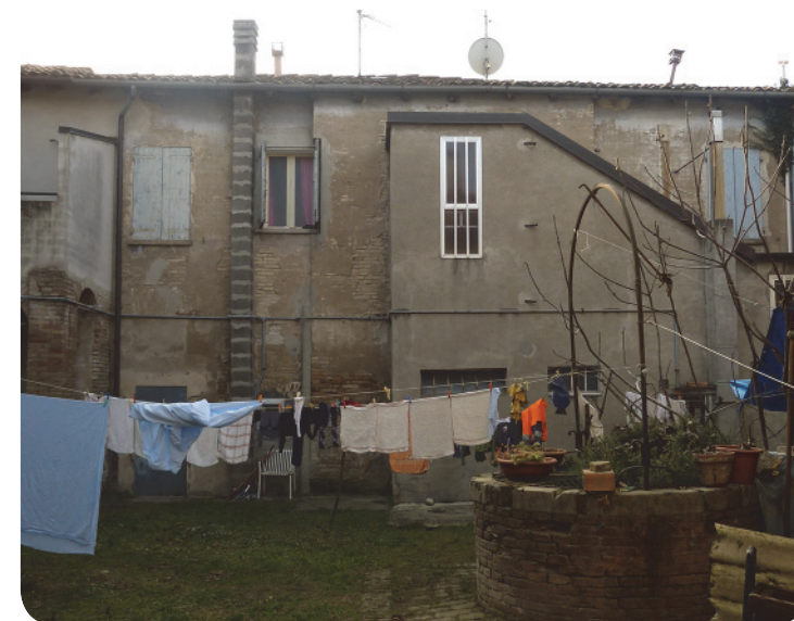
2 - Cortile interno di un edificio storico del borgo; si evidenzia la presenza di superfetazioni anch'esse risalenti ad anni successivi all'apposizione del presente vincolo.
