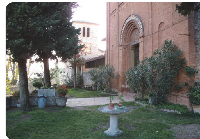
2 . Il sagrato sopraelevato della chiesa di San Pietro: sullo sfondo la torre campanaria.
