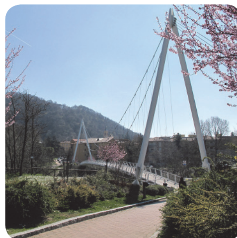
7 . Nuovo ponte pedonale sospeso.
