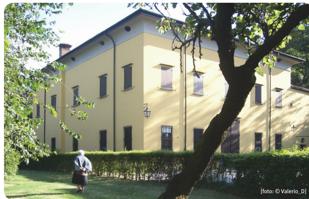
Villa Marullina . Come appare oggi, dopo il restauro.
