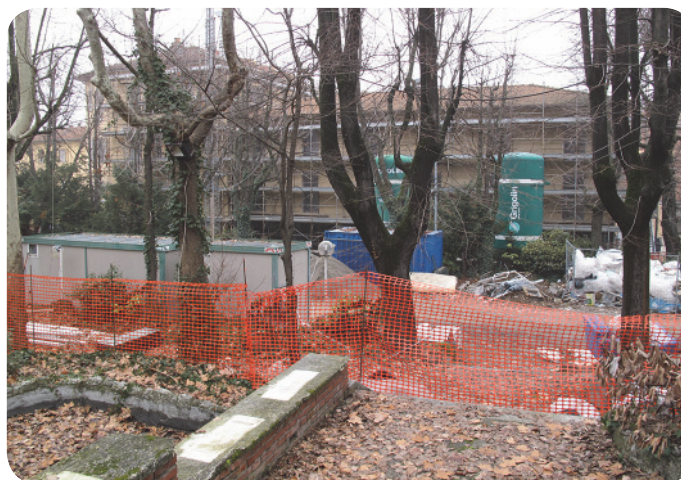
3 . Il cantiere per la ristrutturazione del Savoia Hotel Calzavecchio.
