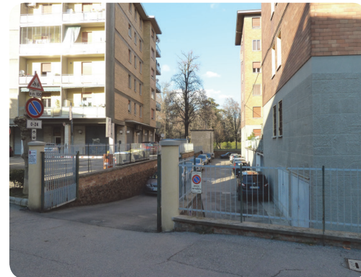
4 . Scorcio del parco visibile da via I Maggio.
