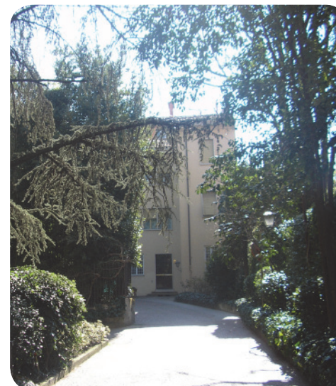
5 . con le spalle al palazzo in via Dante, si osserva sulla sx il verde esterno al vincolo, ma in continuità "naturalistica" con quello tutelato, seppure separato da un muro.
