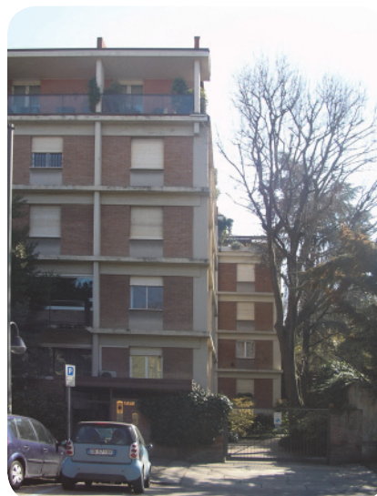
4 . L'edificio residenziale in via Dante, interno al perimetro del vincolo e costruito successivamente alla sua apposizione.
