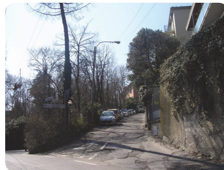
5 . L'accesso alla strada interna di lottizzazione, prolungamento di via Castiglione.
