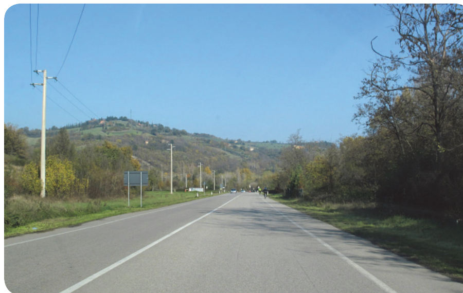
1 . Costeggiando il torrente Savena (a dx vegetazione riparia), provenendo da sud; sullo sfondo i colli dell'area tutelata.
