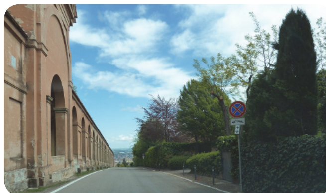
1 . La scansione esterna degli archi del portico di San Luca.
