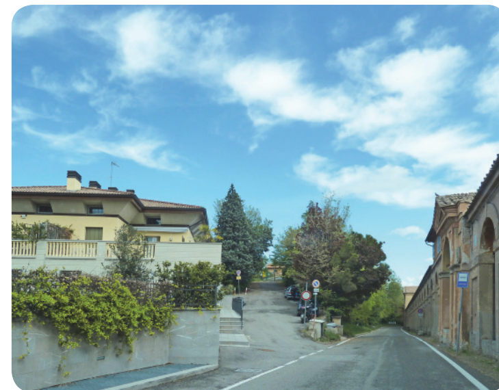
7 . Un'urbanizzazione con muretto di cinta in cemento di forte impatto...
