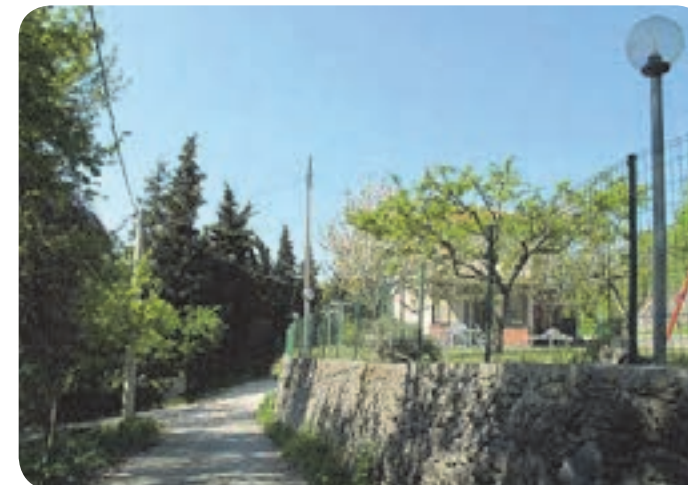
2 . I muretti a secco di contenimento presenti all'interno dell'area.
