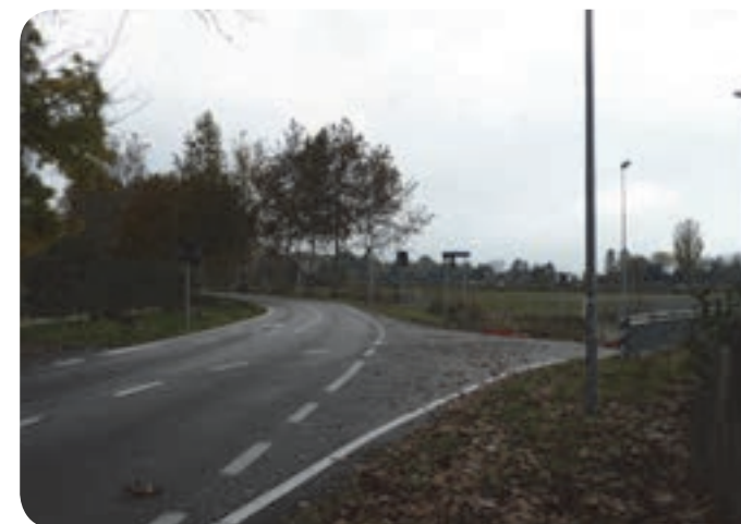
3 . Interruzione del filare di platani per la costruzione del sottopassaggio (a destra).
