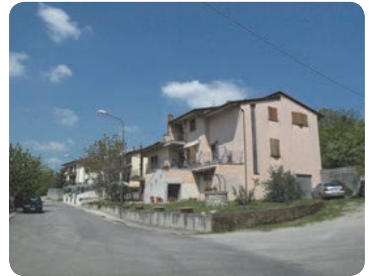
2 . I materiali utilizzati nell'edilizia recente (si notino i muretti) e il linguaggio architettonico connotativo dei fabbricati non si inseriscono armoniosamente nel paesaggio di riferimento.
