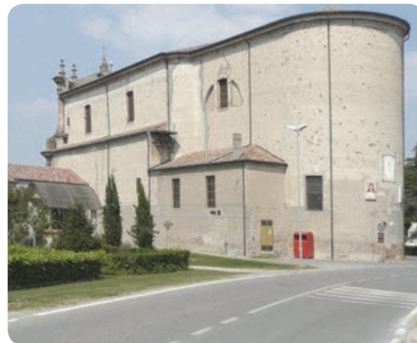
8 . La chiesa di Guarda Ferrarese, il cui accesso si volge verso l'argine del Po.
