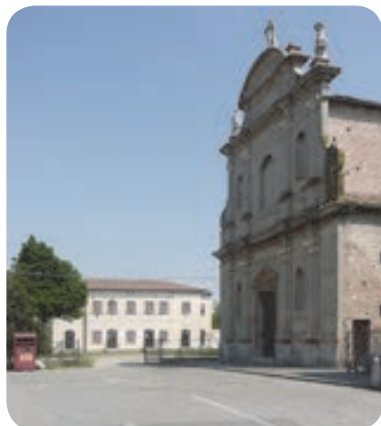
5 . La piazza e la facciata di San Giacomo a Ro. La partenza dello stradello non si affaccia sullo spazio pubblico, ma è sito all'interno di una proprietà privata.
