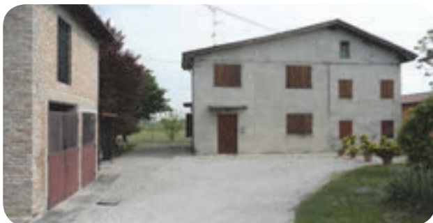
13. ristrutturazione di abitazione dalla tipica morfologia a falde asimetriche; sono evidenti diverse scelte incongrue, sia dal punto di vista compositivo che materico.
