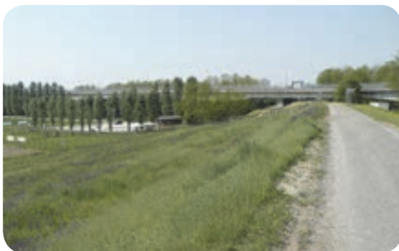
5 . Il ponte Ro-Polesella, dall'argine dx del Po. A sx, si nota un'area attrezzata, circondata da pioppi: la risalita che la connette all'argine serve per risolvere il punto di rottura della pista ciclabile internazionale Destra Po.
