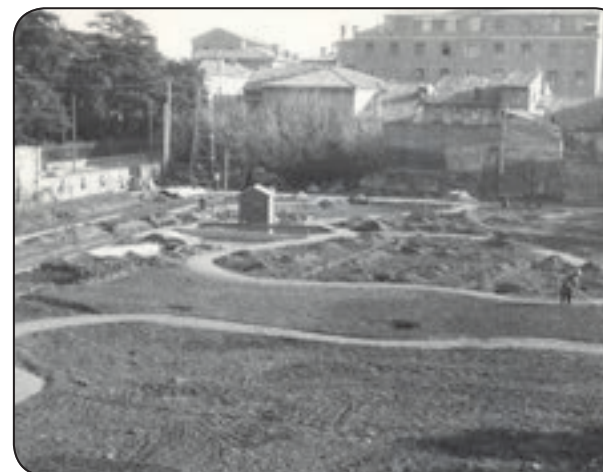
2 . 1962. Lavori di realizzazione dell'Orto Botanico.
