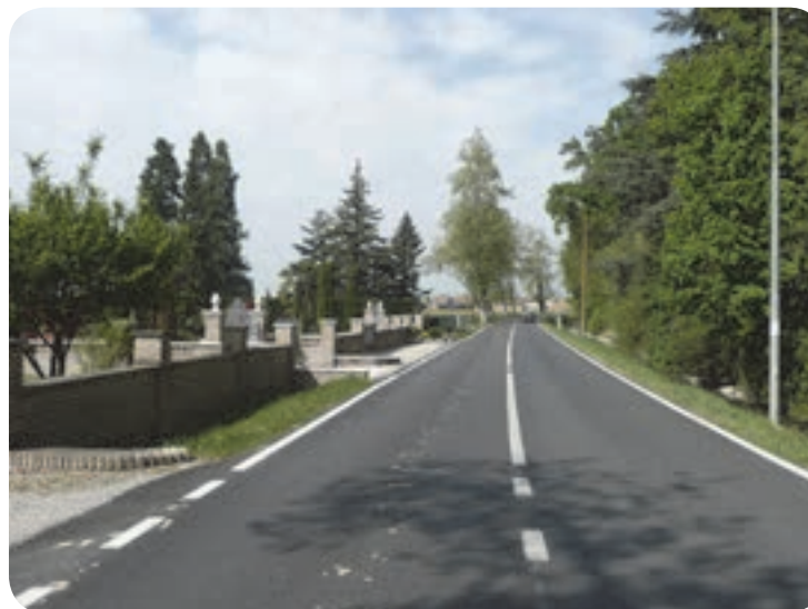
1 . SP29: a sinistra i muretti delle villette unifamiliari di recente costruzione; a dx il parco.
