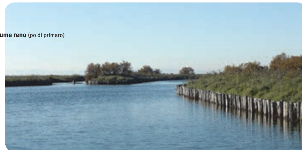
3 . Per rendere più stabili gli isolotti che punteggiano le valli al fine di poterli utilizzare per la costruzione dei casoni o per altre funzioni, i vallanti li hanno consolidati costruendo argini con pali di legno.
