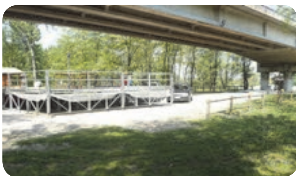
6 . Sotto il ponte, alla sx dell'area attrezzata, vi sono alcune strutture: un palco temporaneo; un punto informativo legato alla storia de «Il Mulino del Po» (si intravede alle spalle del palco); un bar dedicato a Lazzaro e Dosolina (i protagonisti del I volume dell'opera) e la ricostruzione del mulino.
