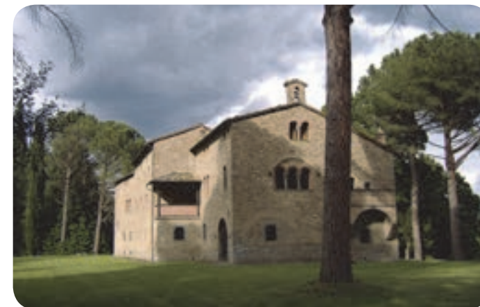
2. Prospetto meridionale dell'edificio, incorniciato da pini domestici.
