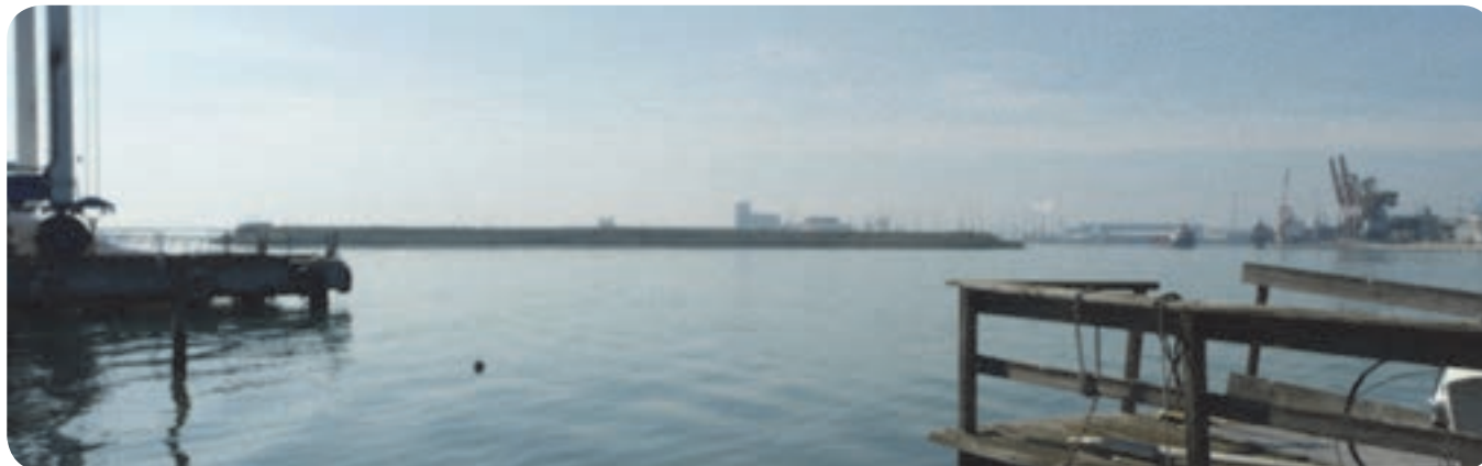
10 . Il canale Candiano, all’altezza dell’intersezione: sulla destra il Candiano prosegue verso il centro di Ravenna; sulla sinistra il canale Piombone immette in piallassa.
