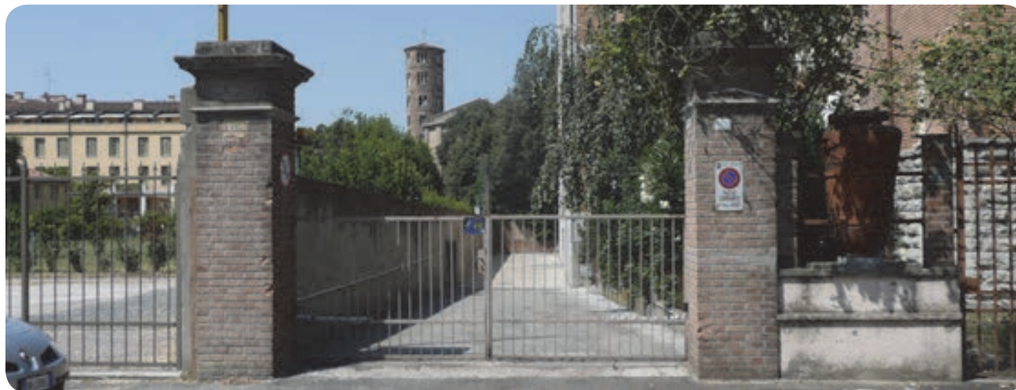
1 . vista da via San Giovanni in Bosco. Sullo sfondo si può ammirare il campanile della Basilica di Sant'Apollinare Nuovo.
