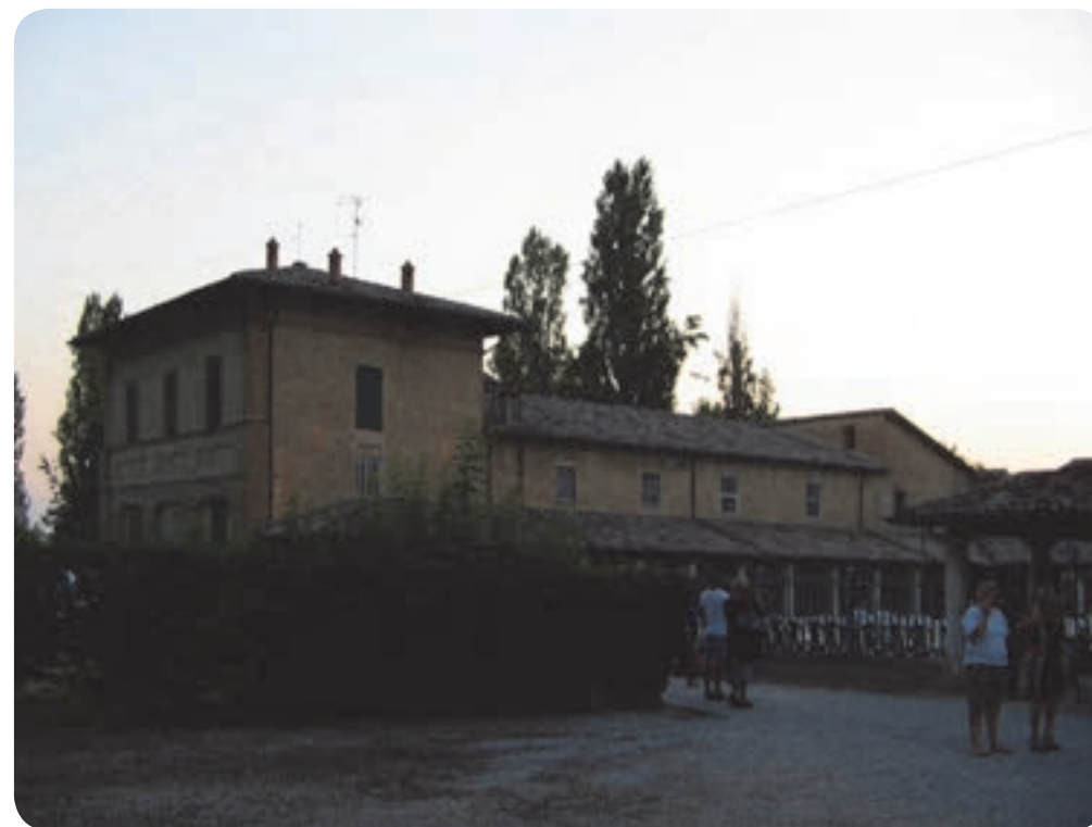
1 . Il rustico di servizio con pianta a U, sviluppatosi alle spalle del corpo central della villa.
