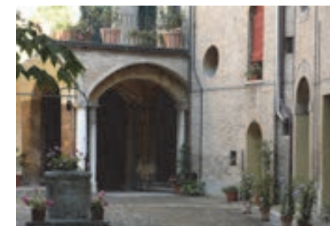
3 . Dettaglio dell'ingresso dal portico principale.
