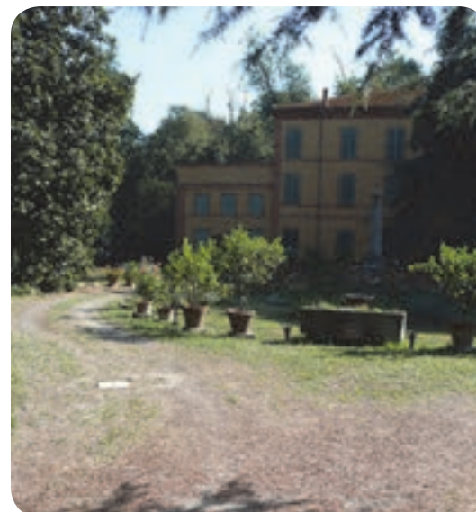
3 . Vista della villa presente all'interno del parco.
