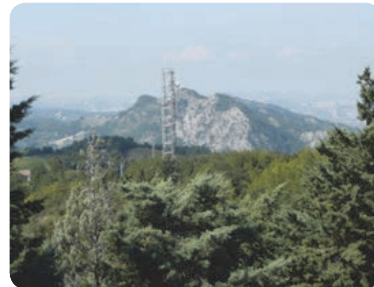
4 . Il traliccio dell'ENEL; sullo sfondo Monte Mauro (bene paesaggistico 174).
