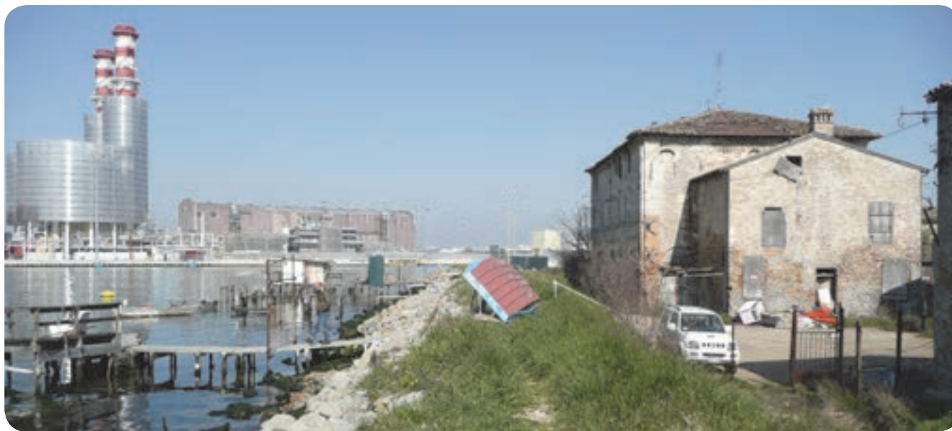
11 . Il complesso di Fabbrica Vecchia e del Marchesato, che si affaccia sul canale Piombone, si confronta con la centrale termoelettrica “Teodora”, sorta sulle rive del Candiano,
