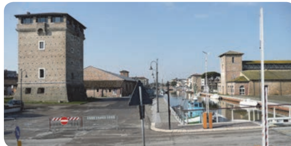
17. Il Canale della Bova all'altezza della Torre di San Michele e dei secenteschi Magazzini del Sale: il Magazzino Torre (a sx) e il Magazzino Darsena (a dx), alle cui spalle è presente una piccola darsena da diporto.
