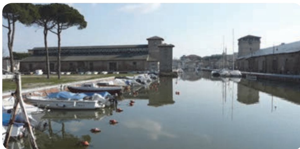
18. L'area dei Magazzini del Sale vista dal ponte di via Giuseppe di Vittorio.
