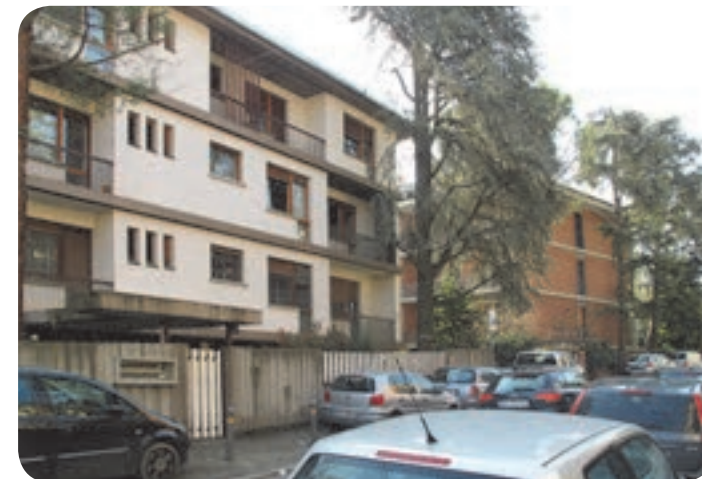
2 . Due dei nuovi edifici realizzati su via Orioli. A confermare l'antica vegetazione protetta del vincolo rimane solo un filare di Cedri del Libano in evidente stato di sofferenza.
