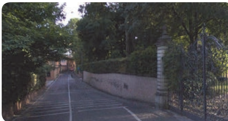
3 . Via Sabbioni e la cancellata d'accesso di Villa Fossalta verso via Santa Barbara.
