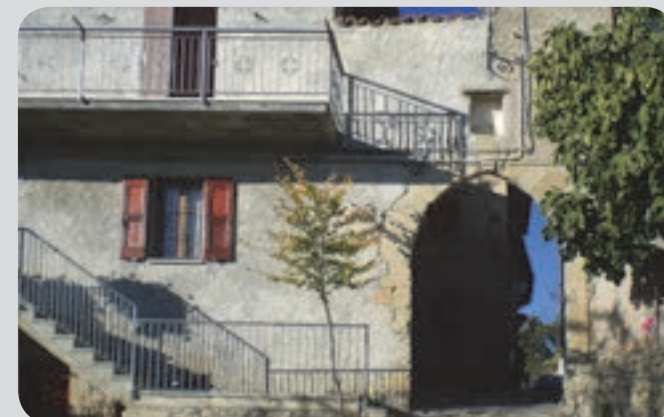
13 . Opere di manutenzione, dalle quali si evince come sia necessario mantenere alta l'attenzione sulle modalità da adottare per lavori edilizi.
