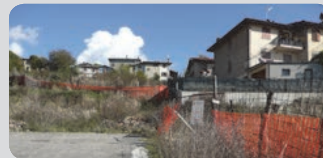
14 . Dettaglio di un cantiere ancora in attività. Nell'intorno lotizzazioni già concluse.
