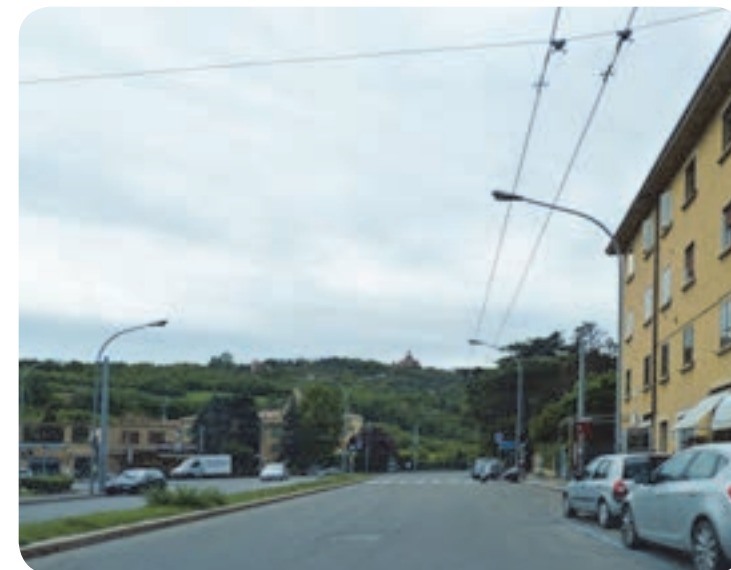
11 . Via Porrettana . confine del bene paesaggistico: l'edificato a sx è parte dell'area tutelata.
