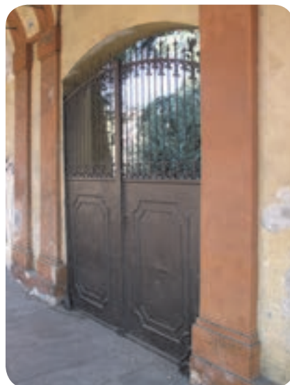
1 . La percezione del bene su via Saragozza è testimoniata solamente dal verde che si intravede alle spalle di una cancellata d'ingresso.
