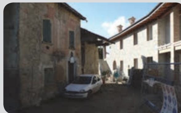
12 . Renno . a sx edificio storico, a dx fabbricato con rivestimento in pietra.
