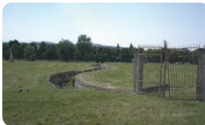
3 . Palazzo Ducale . tratto del canale, connesso alla peschiera, che circondava il Palazzo.
