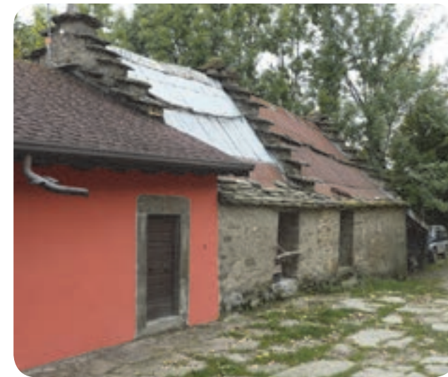
1. Casella . a dx capanna celtica con “penne” intermedie; a sx edificio pesantemente ristrutturato, la cui storicità può essere desunta dall’architrave della porta.
