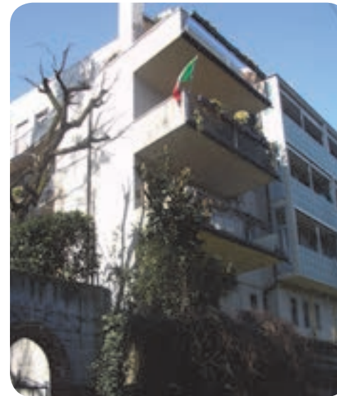
2 . Proseguendo, si osserva l'edificato recente al di sopra del muro di contenimento...
