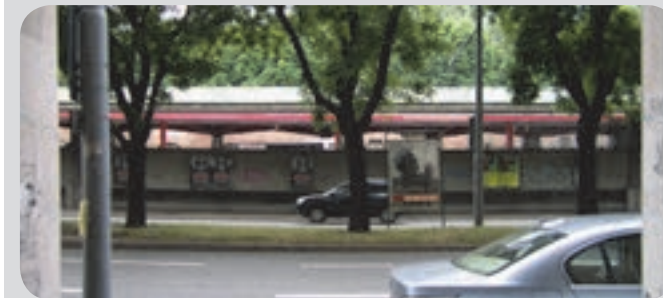
4 . Stazione autolinee: vista del prospetto laterale dai portici di viale Angelo Masini.
