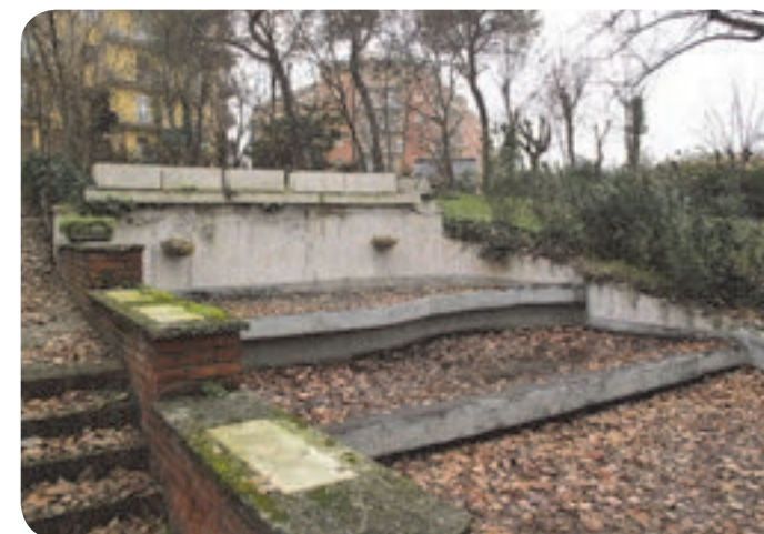
4 . La fontana (oggi in cattive condizioni) e la scalinata; entrambe rivolte verso l'hotel.
