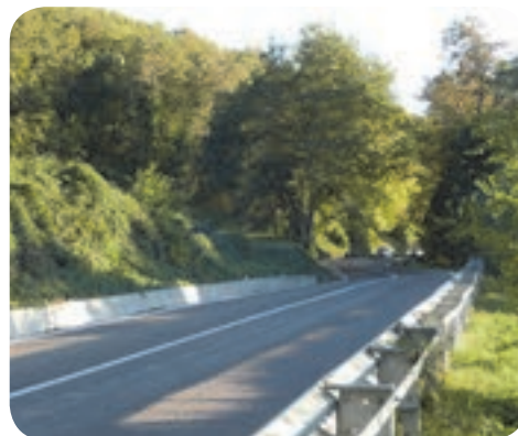
6 . Percorrendo la strada dell'Abetone verso Montecuccolo.
