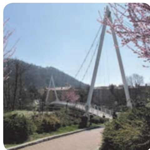
7 . Nuovo ponte pedonale sospeso.
