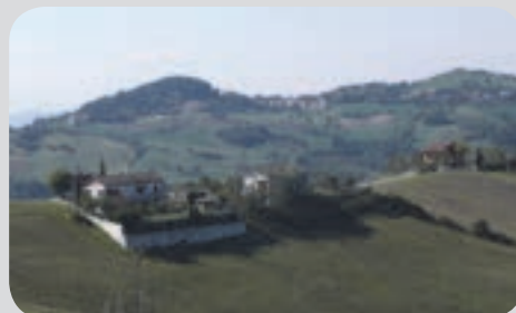
14 . Edilizia residenziale . muro di contenimento incongruo.
