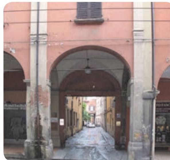
2 . L'entrata di via S. Vitale 40/2; dopo aver superato il portale di accesso, in fondo a sinistra si scorge la chioma di un albero della prima area tutelata.
