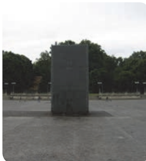
3 . Da piazza VIII agosto: la colonna di aerazione del parcheggio sotterraneo intralca la visibilità della prospettiva centrale.
