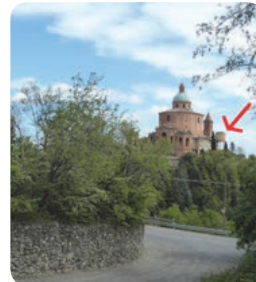
5 . La basilica vista da sud: si osserva la cisterna addossata alla parete della basilica, elemento incongruo rispetto al paesaggio.
