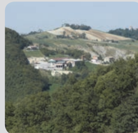
14 . Attività produttive . capannoni a Fazzano.
