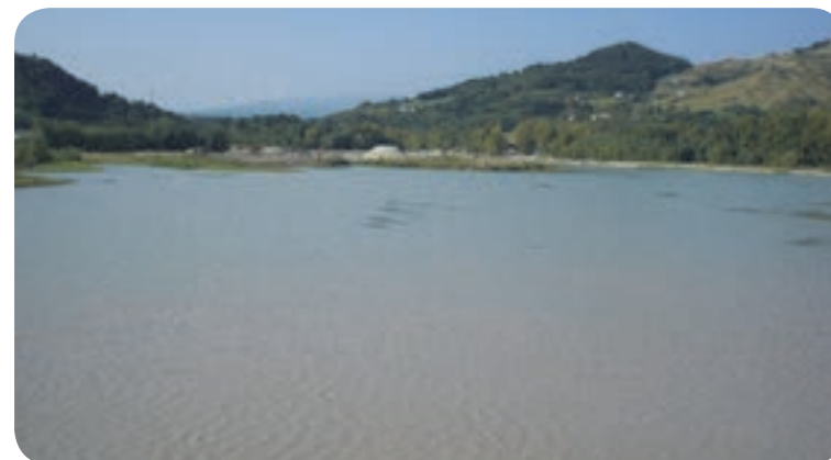
13 . Invaso creato con la costruzione della traversa di Castellarano (a sud del perimetro del bene).
