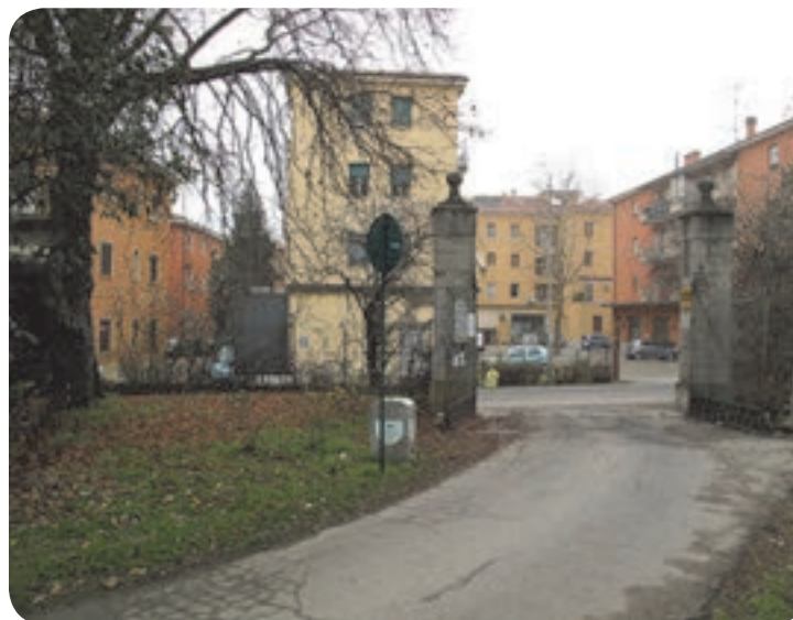
3 . L'ingresso al parco si affaccia verso il tessuto urbano consolidato di Casalecchio di Reno.
