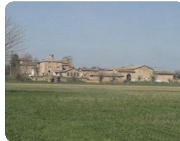
6 . Annessi rurali del complesso ducale di Rivalta.
