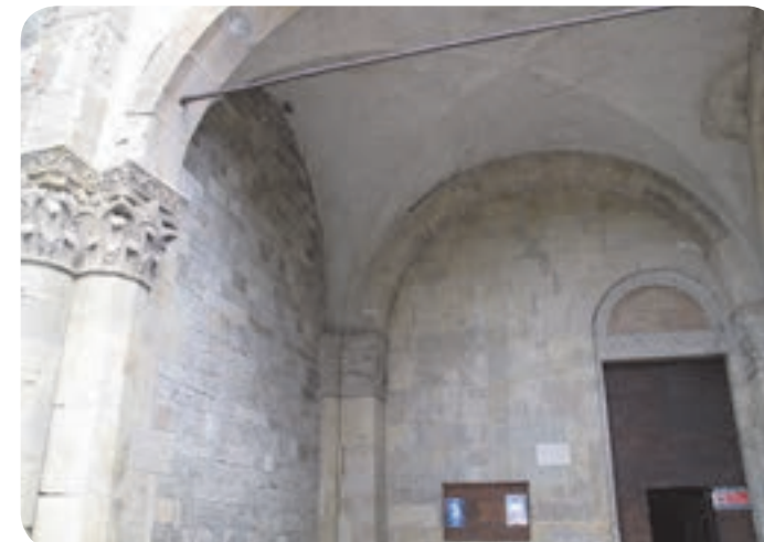
2 . Particolare del pronao della Abbazia di San Basilde (in fase di restauro).
