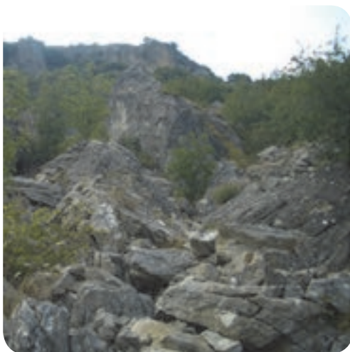
3 . Frana della formazione di Bismantova.
