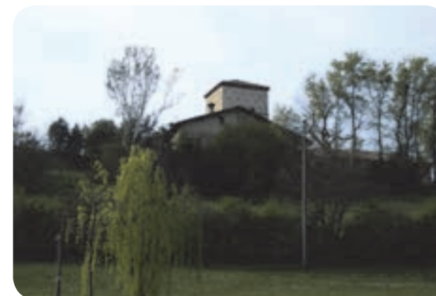
6 . La Rotonda, vista da est.
