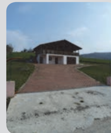
11 . Pavimentazione sproporzionata di accesso a un'abitazione con caratteri incongrui.
