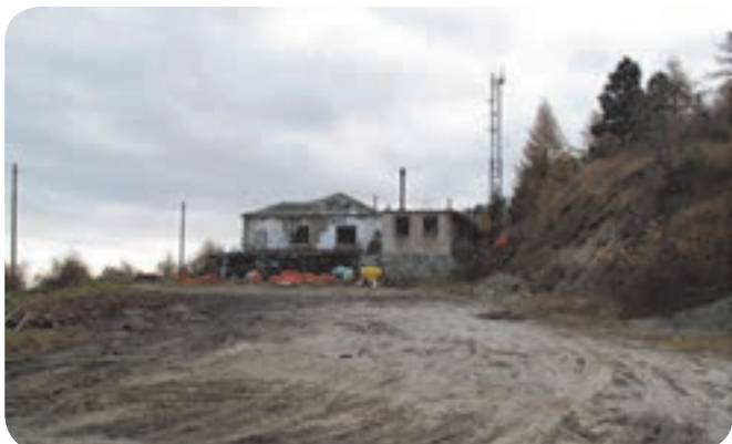
6 . sulla cima di Monte Penice sorge un edificio degradato e abbandonato, in un'area altrettanto abbandonata
