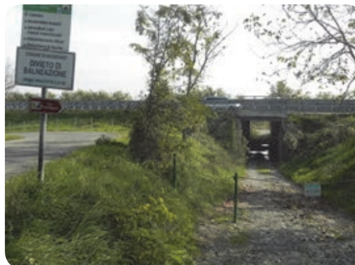
3 . Un accesso all'area in sottopasso alla Autostrada (Comune di Medesano).
