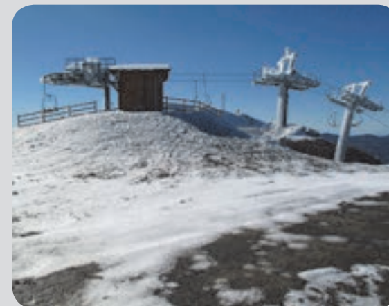
11 . La stazione del nuovo impianto di seggiovia sul Monte Bue.
