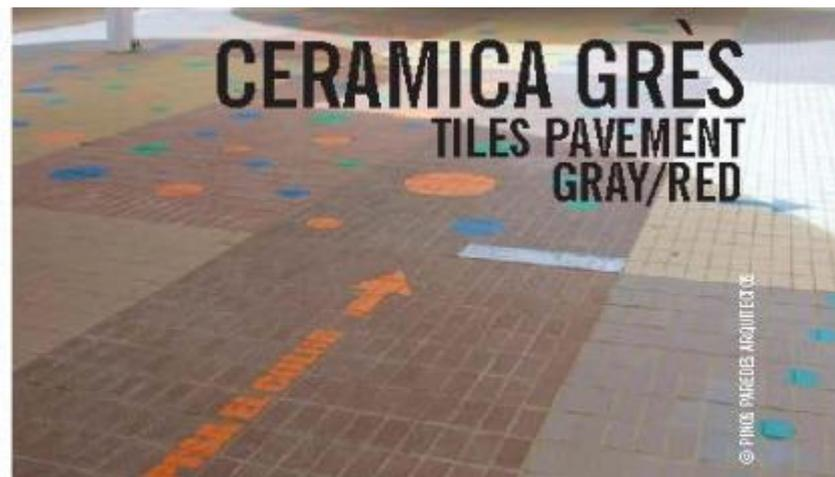
Il gres porcellanato è un materiale ceramico, compatto, resistente e caratterizzato da una porosità e valore di assorbimento di acqua molto basso. Grazie alle sue caratteristiche di resistenza e durabilità è un materiale molto utilizzato.
