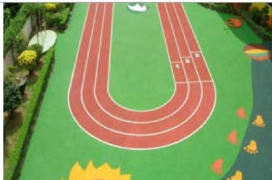
Le pavimentazioni in gomma antitrauma sono superfici che si utilizzano per limitare i danni da caduta (in particolare dei bambini) in determinate aree.
