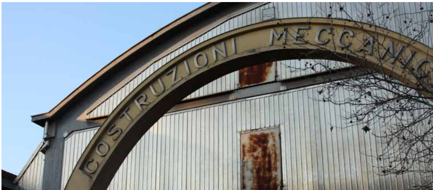
L'EX PADIGLIONE MANZINI, PROSPETTO SU VIA PALERMO, DIFRONTA ALLA LINEA FERROVIARIA
