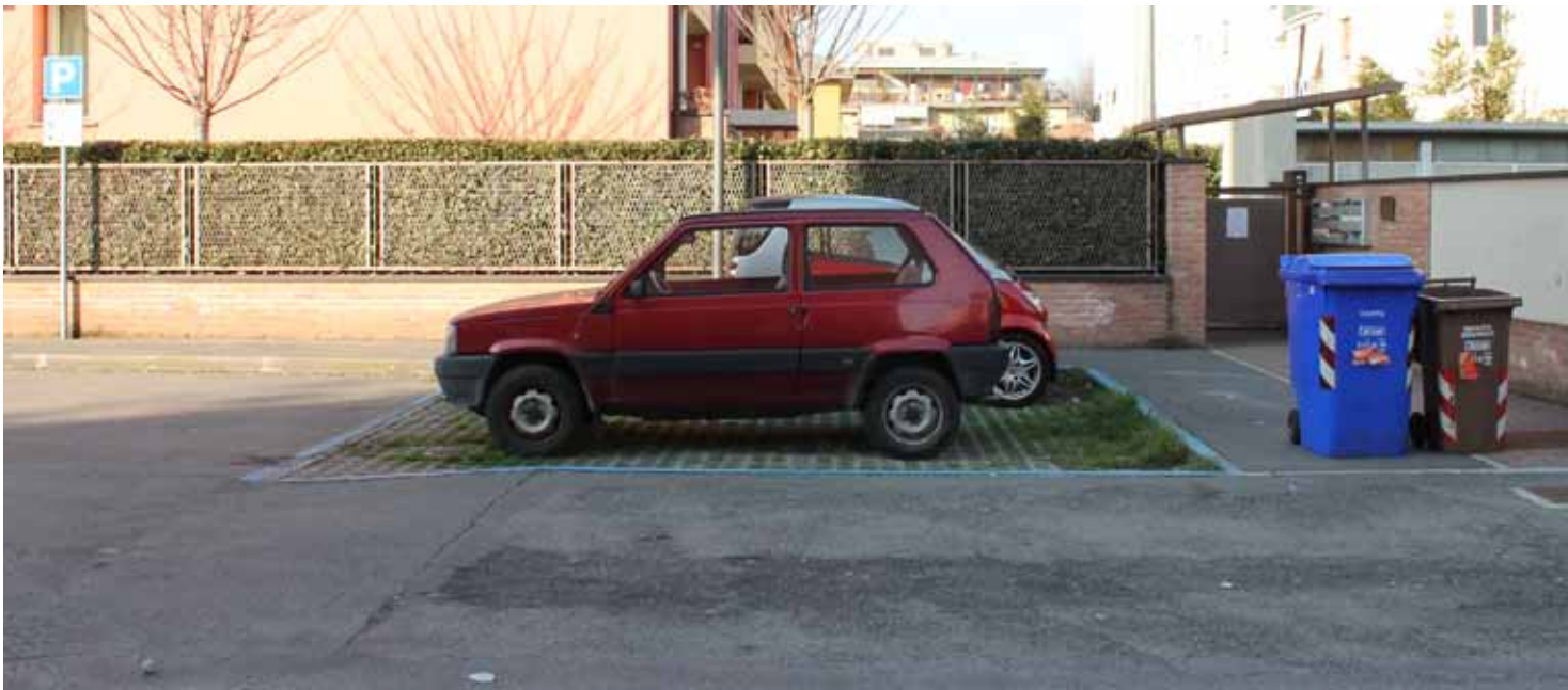
PARCHEGGI A RASO SU AUTOBLOCCANTI IN VIA PASUBIO
