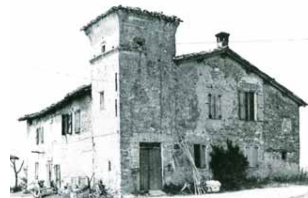
Fig. 10: Esempio di sistema aggregativo storico a blocco, mediante accostamento di due corpi di fabbrica su due lati contigui di una casa a torre.
