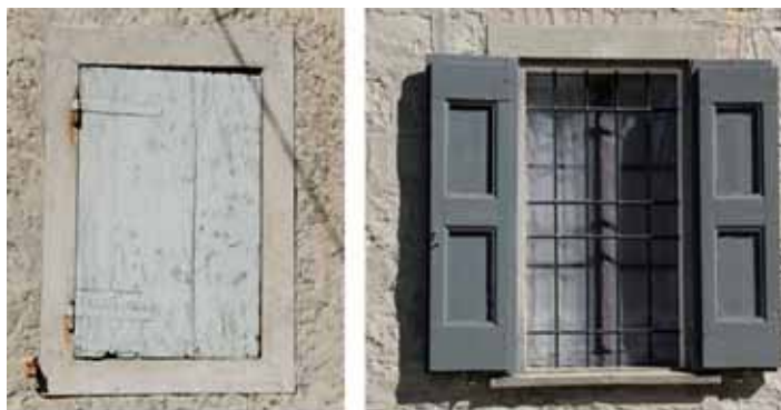
Figg. 49-50: Sì. Esempi tradizionali di aperture con scuri in legno. Si nota che l'infisso a tagliere è sullo stesso piano delle mostre e la finitura laccata interessa anche la ferramenta.
