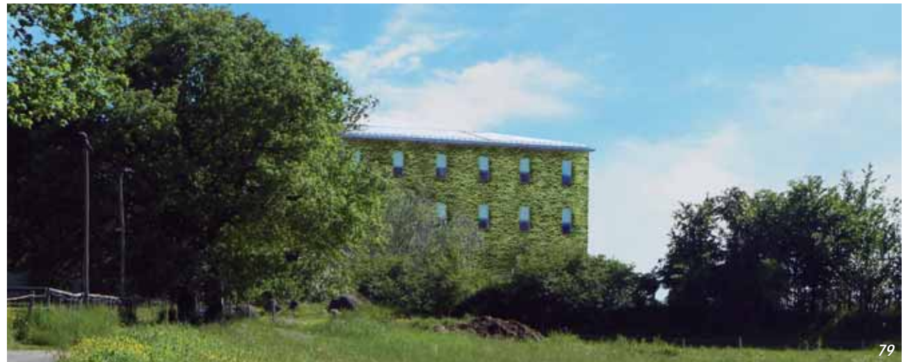
Figg. 78-79: No e sì. L'eccessivo impatto visivo dell'edificio (78) potrebbe essere mitigato da cortine vegetali da realizzarsi attraverso la semplice messa a dimora di piante rampicanti a ridosso dei prospetti (79).
