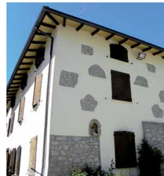
Fig. 60: No. Finiture da evitare: intonaco inframmezzato da brecce a faccia vista.
