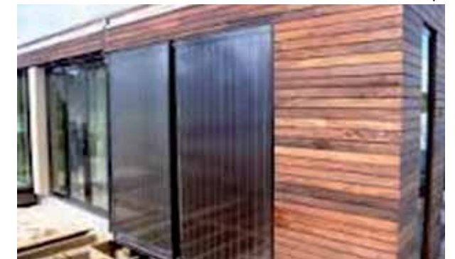
Fig. 125: Sì. Una pellicola fotovoltaica integrata in un'apertura verticale.
