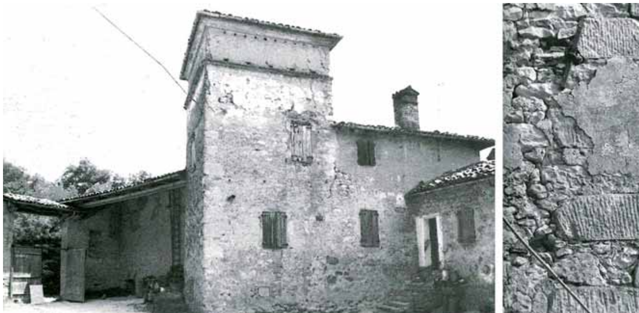
Fig. 56-57: Casa con torre colombaia in cui si conservano le finiture storiche delle pareti. Dettaglio dell'apparecchio murario protetto da un sottile strato di intonaco a calce.
