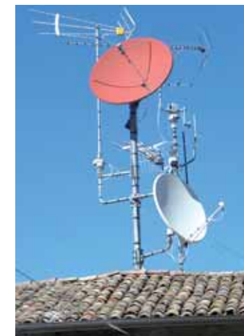
Fig. 121: No. Disordine sulla copertura.
