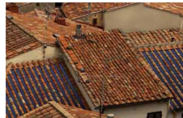
Fig. 122: Sì. Esempio di installazione di modulo fotovoltaico a fascia, integrato nel manto di copertura.
