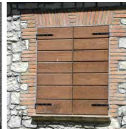
Figg. 54-55: No. Soluzione impropria degli scuri realizzati con doghe strette e bisellate, ferramenta in colore diverso dall'infisso, battuta sporgente dal piano di facciata.
