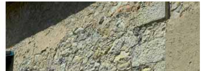
Fig. 65: L'apparecchio murario era comunemente protetto da un sottile strato di intonaco a calce che assecondava le irregolarità della parete.
