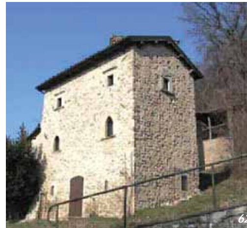
Figg. 61-62-63: Intervento di recupero in un edificio di interesse storico. La soluzione adottata per le pareti esterne ha modificato i rapporti tradizionali tra le superfici intonacate e le mostre in pietra sottraendo anche le ultime tracce di intonaco.
