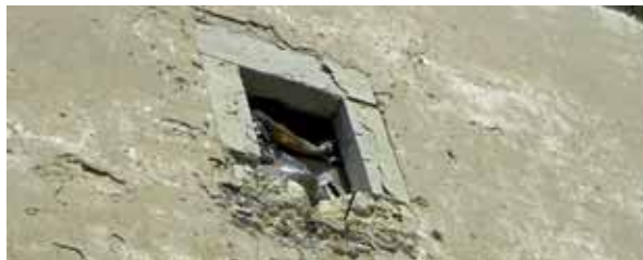
Fig. 64: Rapporto tra finestre con mostre in pietra e superfici intonacate delle pareti come appaiono negli edifici storici.
