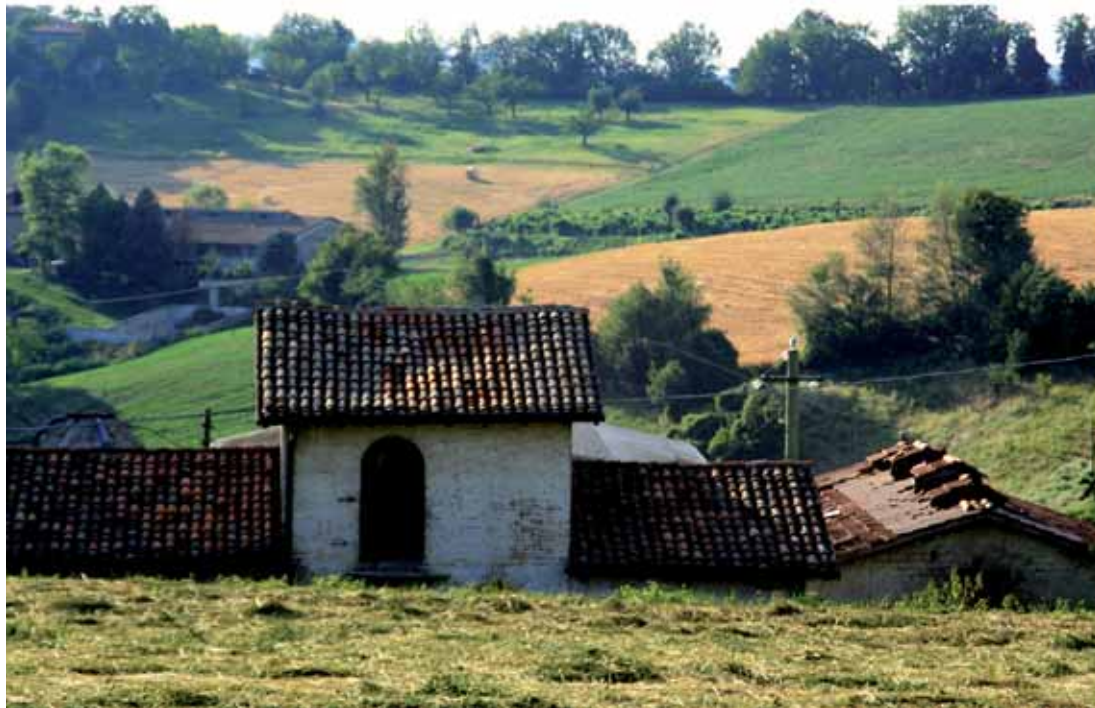
Fig. 23: Casa in linea. Accesso da pendio al primo livello.
