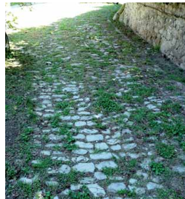
Fig. 118: Si. Una strada tradizionale risistemata, con i conci in pietra allestiti nel terreno inerbita con il tempo.
