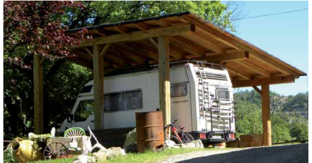
Fig. 74: Si. Tettoia con materiali scelti correttamente che copre gli automezzi senza chiudere gli spazi. Una buona soluzione spesso nasce dal limitare l'intervento alle funzioni essenziali.
