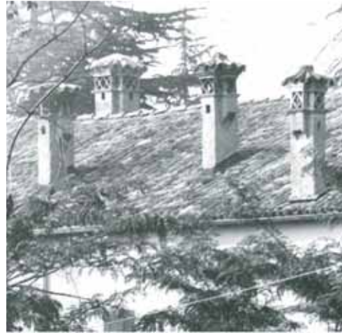
Fig. 38: Esempio di comignoli storici originari, realizzati con tipologia analoga e differenti dimensioni.
