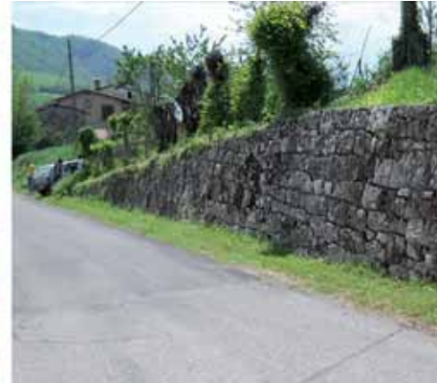
Fig. 100: Si. Muretto con tecniche e materiali tradizionali senza legante, parzialmente coperto dalla vegetazione, tipico della zona dei Sassi.
