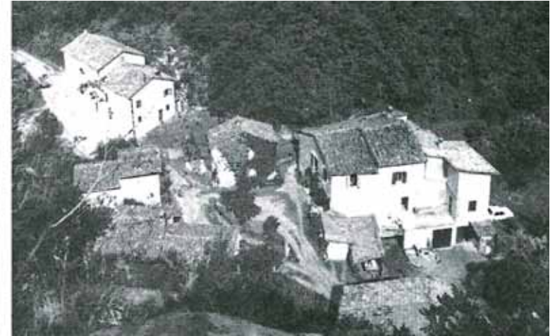
Fig. 39: Esempio di borgo caratterizzato dalla geometria semplice del tetto a due falde.
