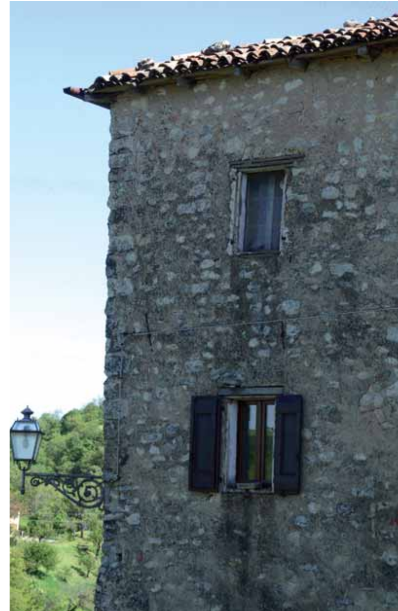
Fig. 41: Cortina muraria ad opus incertum con finitura intonacata. L'immagine documenta l'aspetto caratteristico assunto dagli edifici storici a seguito del progressivo dilavamento dell'intonaco.
