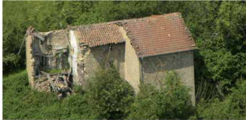
Fig. 22: Casa in linea. Esempio di aggregazione a corpi continui con l'aggiunta di cellula elementare.
