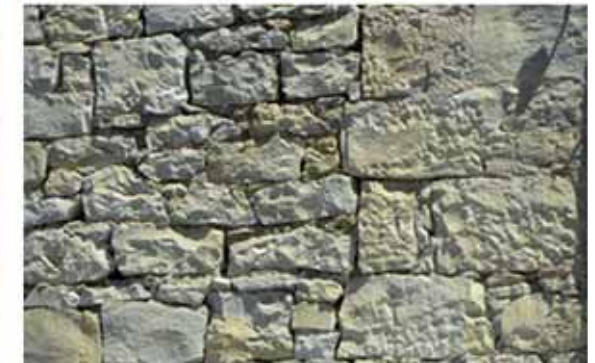
Fig. 48: Dettaglio di una muratura a filaretto con i cunei per il serraggio dei conci.
