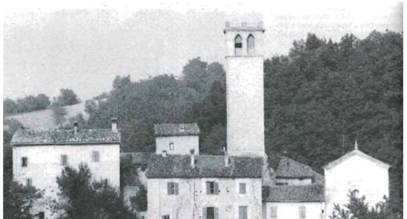
Fig. 40: Esempio di borgo caratterizzato dalla geometria semplice del tetto a due falde.
