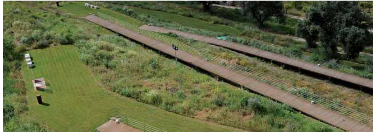
Fig. 124: Sì. Legno e linee che fungono al loro interno da vasche di laminazione e che incanalano le linee elettriche e fognarie in un paesaggio naturale (Castello di Silves, Spagna, progetto di PROAP Studio).
