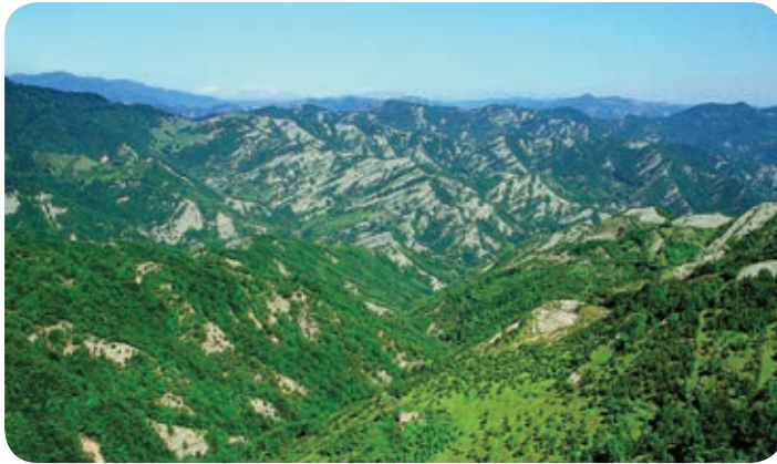
Fig. 97 - Versanti fortemente soggetti all'erosione del medio Appennino romagnolo.
