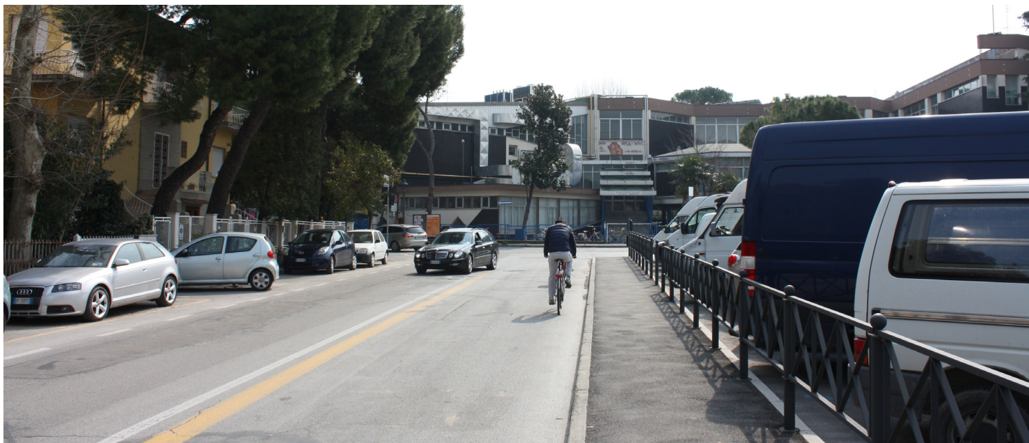
CARREGGIATA SU PIAZZALE GRAMSCI TRA VIA CORNELIA E VIA BRIGHENTI
