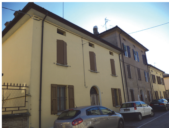
alloggi IACP siti nel comune di Crevalcore (BO)
