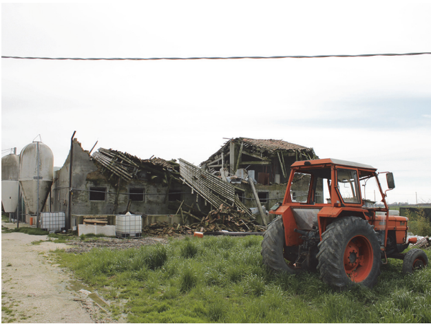
Foto 2. Uno degli edifici ancora da demolire
