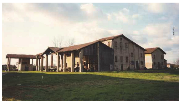
Vista del borgo e il segno distintivo degli alti pilastri
