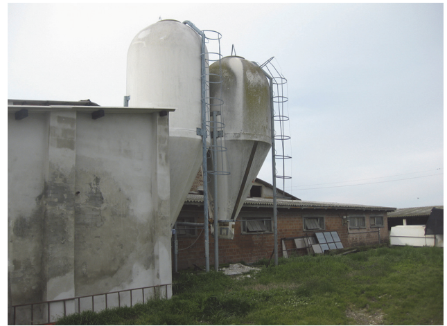
Foto 3. Il secondo edificio che ancora attende la demolizione
