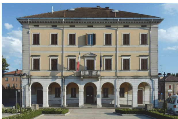
La sede municipale prima dell'evento sismico.
