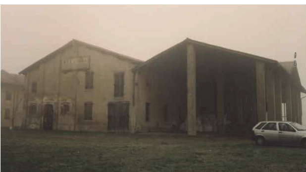
Ricovero animali con annessa tettoia [edificio 5]
