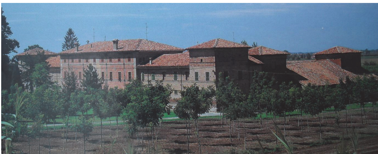
Palazzo Pio sito nel comune di Novi di Modena
