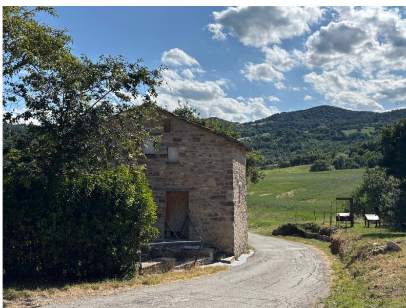
Tratto di strada storica nel comune di Montecopiolo con un "Balcone Rinascimentale" del progetto Montefeltro Art Views. Elaborazione propria.
