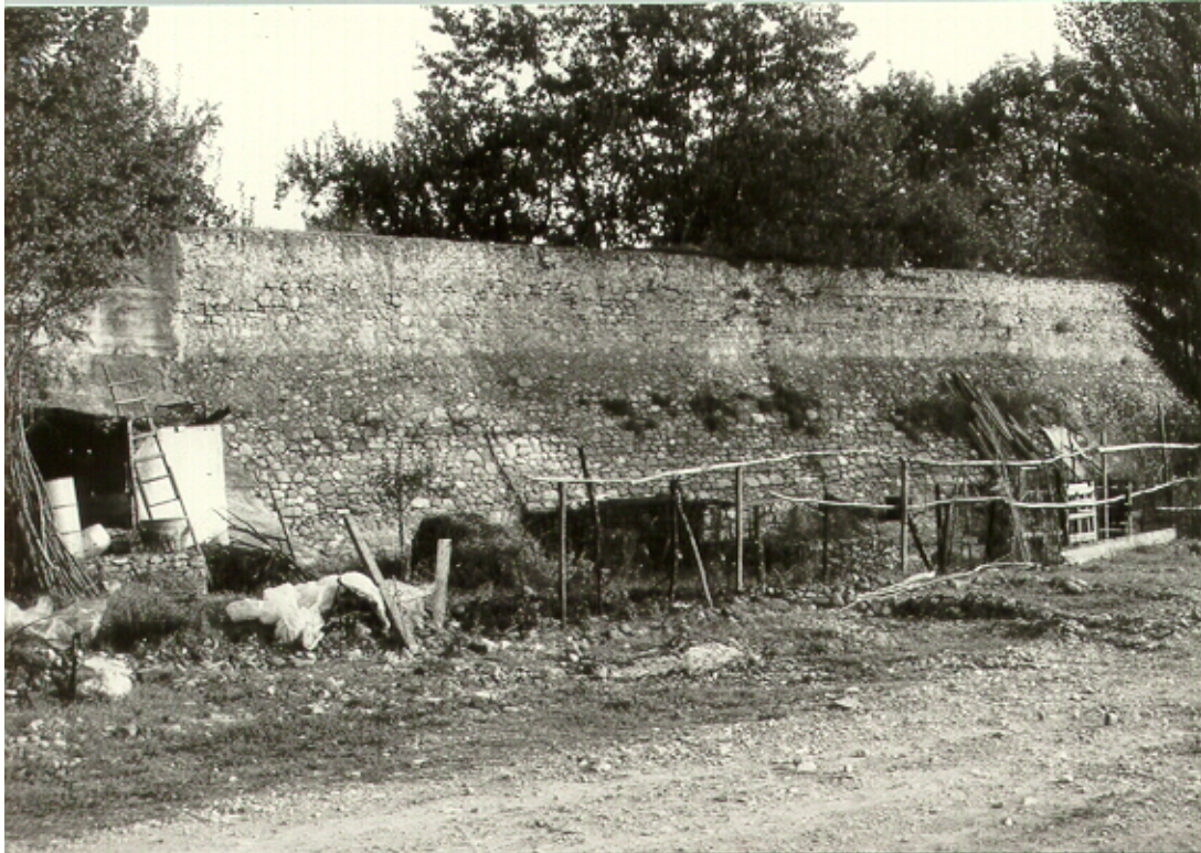
Figura 5: Foto dei muri di difesa del Panaro a valle del ponte, sponda sin. È visibile il vecchio livello del fiume (parte più scura) fino al 1950 circa. La foto, della collezione “Banchi e Neri” è del 1984
