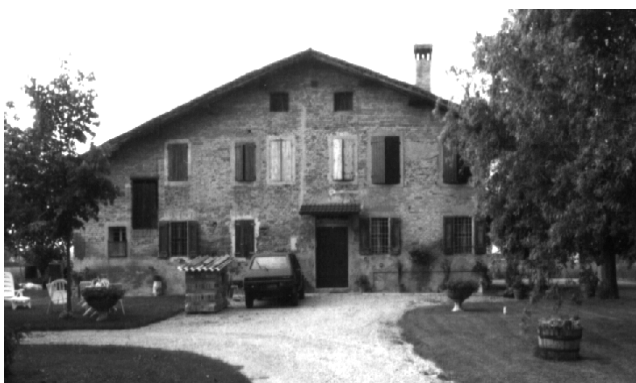
Tipo di casa d'abitazione in località Dodici Morelli, prospetto sud.
