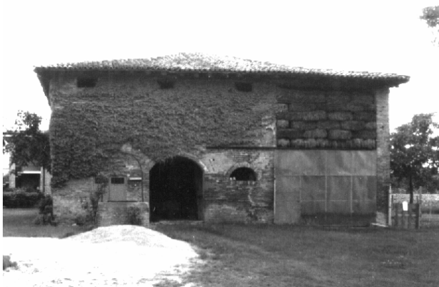
Tipo di edificio di servizio agricolo in località Bevilacqua.
