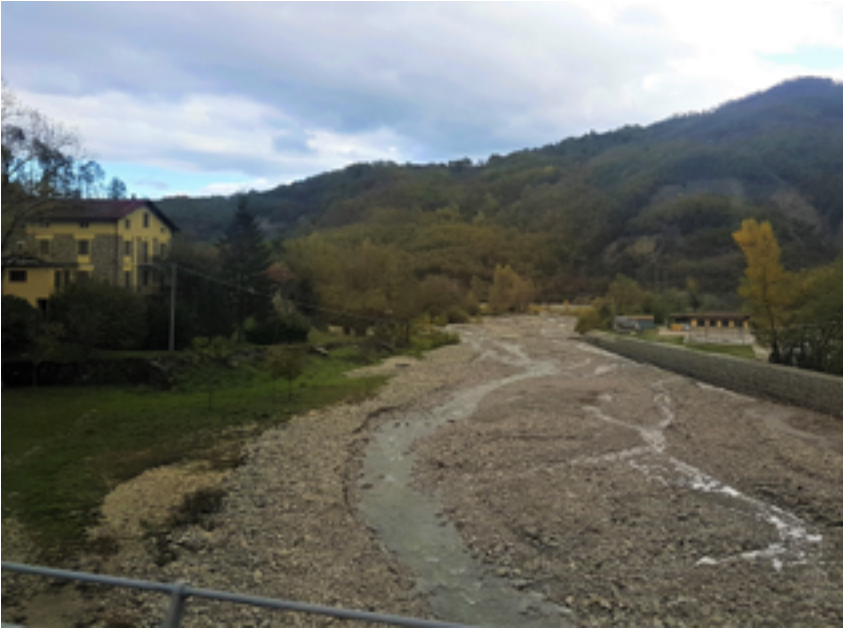
Figura 57. Fiume ghiaioso verso Corniglio con insediamenti residenziali e produttivi.
