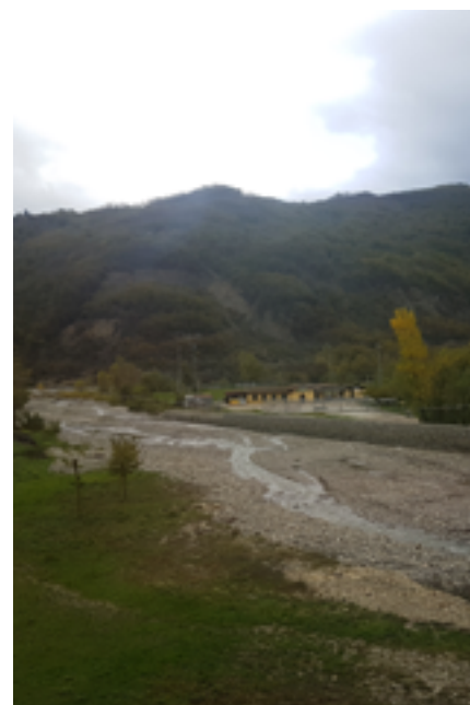
Figura 24. Vista sul Rio Lucconi dal Ponte di Ghiare di Corniglio.
