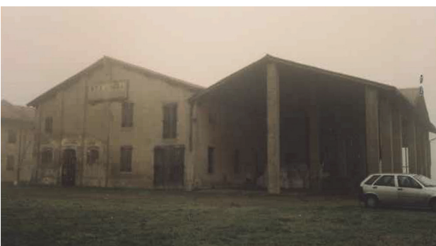
Ricovero animali con annessa tettoia [edificio 5]
