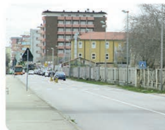
occupazione intensiva del lungomare
