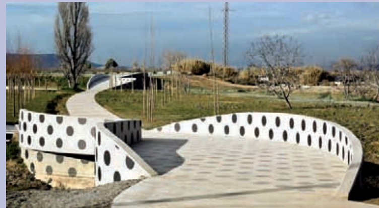
El proyecto asegura la continuidad entre las riberas con la construcción de dos puentes sobre los colectores existentes. The project ensures continuity between the two banks thanks to the construction of two bridges over existing channels.
