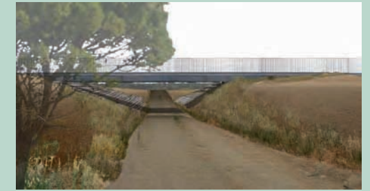
Paso en trinchera por debajo de la carretera de conectividad de fauna y peatones. Trench crossing below the road for wildlife and pedestrian use.
