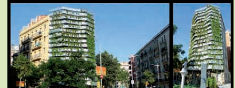
Actuaciones recientes. Se plantea un jardín vegetal con una estructura metálica como soporte con diversos niveles que sustentan la vegetación. Con la transformación de esta medianera se crea un nuevo ecosistema con beneficio social y ambiental para la ciudad. A la izquierda de la imagen, medianera antes de su recuperación. Recent activities. A garden was planted using a metal structure as a supporting framework for various levels of vegetation. The transformation of this wall created a new ecosystem, providing social and environmental benefits to the city. To the left of the picture, the party wall prior to rehabilitation.
