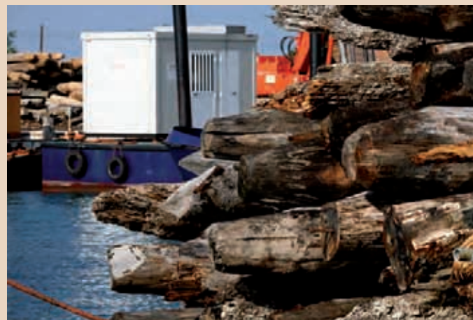
Cantiere alle Vignole. Building site on Le Vignole.
