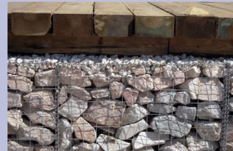
Detalle del apoyo de las rampas de madera sobre el muro de gaviones. Detail of the timber ramp support on the gabion wall.
