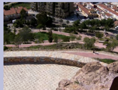
Adecuación de la red de caminos que conducen a la torre. Improvement of the path way up the tower.
