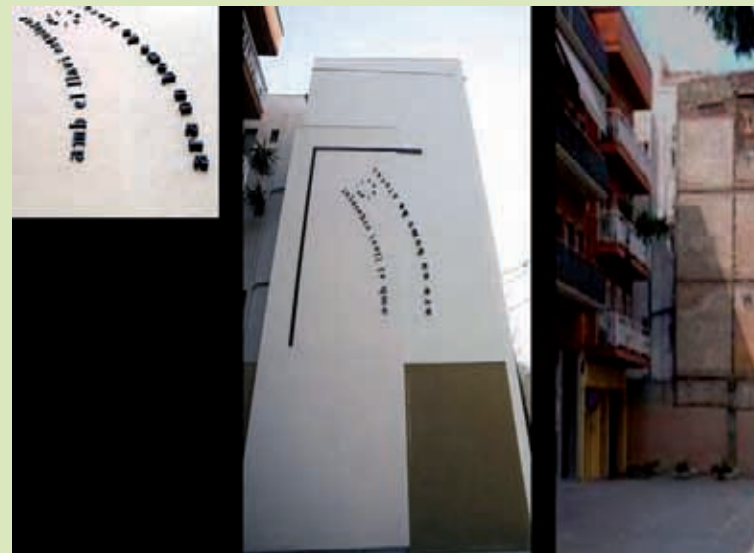
Actuación singular próxima a las instalaciones del FC Barcelona, con la instalación del caligrama "fútbol" con letras corpóreas sobre un fondo de materiales y colores que recuerdan los de la época en que se construyó el edificio. Singular intervention close to the FC Barcelona football stadium, inspiring the installation of the calligram "fútbol" with three-dimensional letters on a background of materials and colours reminiscent of the era in which the building was constructed.
