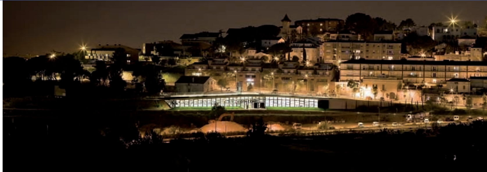
Nueva vista panorámica nocturna con la biblioteca como ventana de luz. New night-time view, with the library as a window of light.
