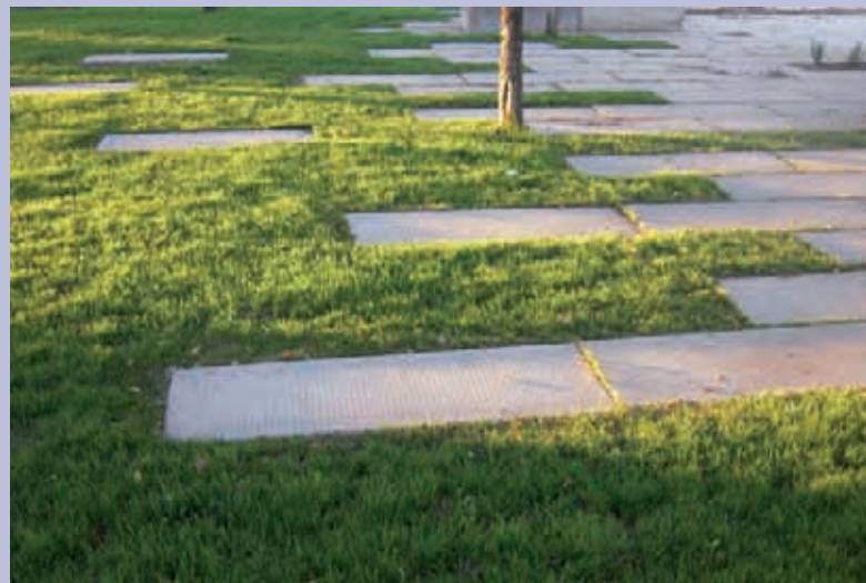
Detalle. Descomposición del pavimento de hormigón impreso en la superficie vegetal. Concrete pavement decomposition printed in the vegetable surface.
