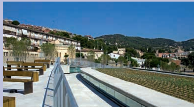
Terraza ajardinada de la biblioteca con la comunicación longitudinal recuperada. Landscaped terrace of the library, with the recovered longitudinal link.
