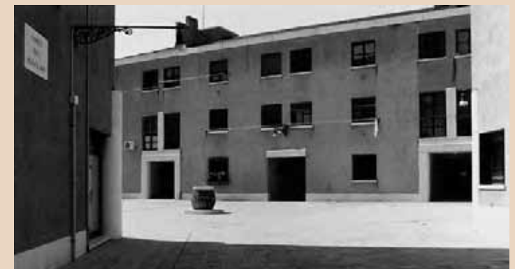
Francesco Barasciutti, il nuovo quartiere nell'Area Saffa - 2005. Francesco Barasciutti, the new residential quarter of the Saffa industrial area - 2005.
