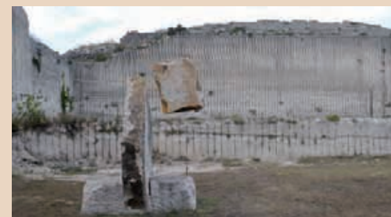
Alcune opere permanenti. Some permanent works
