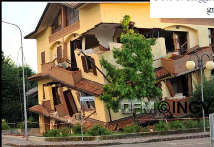
Foto 2. Rovereto sulla Secchia. Danno di grado 5 in edificio in muratura tipo C
