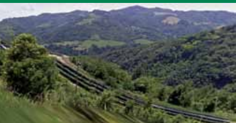
campo fotovoltaico a 2,4 km da San Romano
