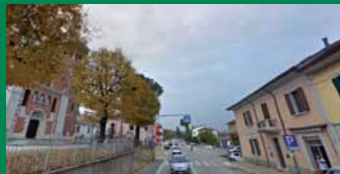
insediamento lineare lungo la strada statale 71 a Borello
