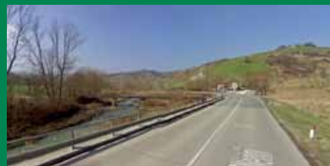
torrente Borello dalla strada provinciale 29 presso Borgo delle Rose
