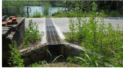
Tunnel di attraversamento stradale per anfibi
