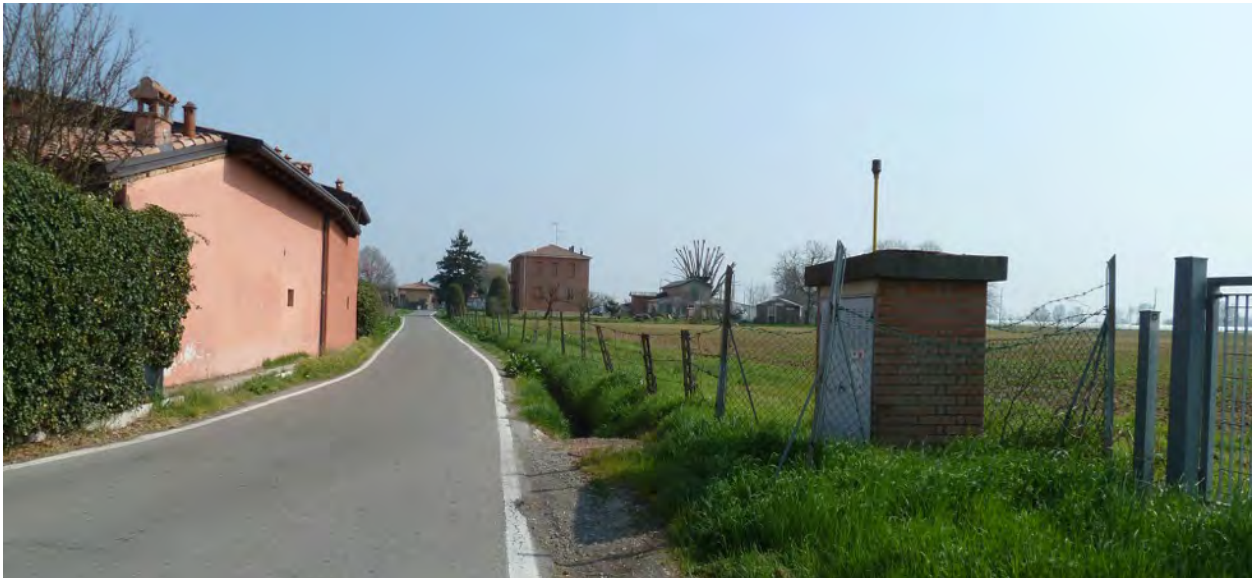
VIA FRABAZZA ALL'INCROCIO CON VIA CADRIANO. A SINISTRA SI INTRAVEDE UNA PORZIONE DELL'EDIFICATO DI ORIGINE STORICA ATTESTATO SU VIA CADRIANO, SULLO SFONDO ALCUNI EDIFICI TRASFORMATI IN RESIDENZA URBANA (FOTO DANIELA CARDINALI)
