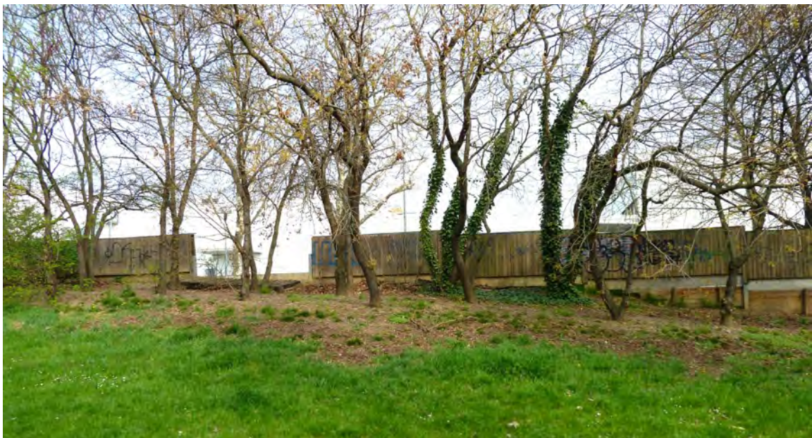
UN TRATTO DI BARRIERA ACUSTICA CHE SEPARA IL QUARTIERE DAL PARCO COMMERCIALE MERAVILLE (FOTO DANIELA CARDINALI)
