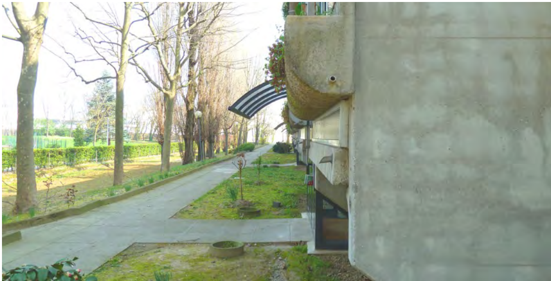
ACCESSI PEDONALI AGLI EDIFICI IN LINEA A NORD-EST DEL RIONE. OLTRE LA SIEPE UN PERCORSO PEDONALE DI QUARTIERE CHE COLLEGA VIA CAMPANA AL MERAVILLE (FOTO DANIELA CARDINALI)
