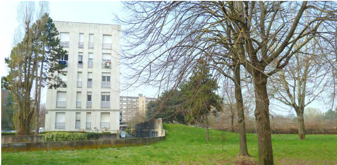
IL TERRAPIENO A RIDOSSO DEL GARAGE DI VIA ADA NEGRI, A LATO DEL "VIRGOLONE" (FOTO DANIELA CARDINALI)
